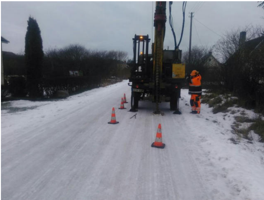
1 pav. Lauko darbai
