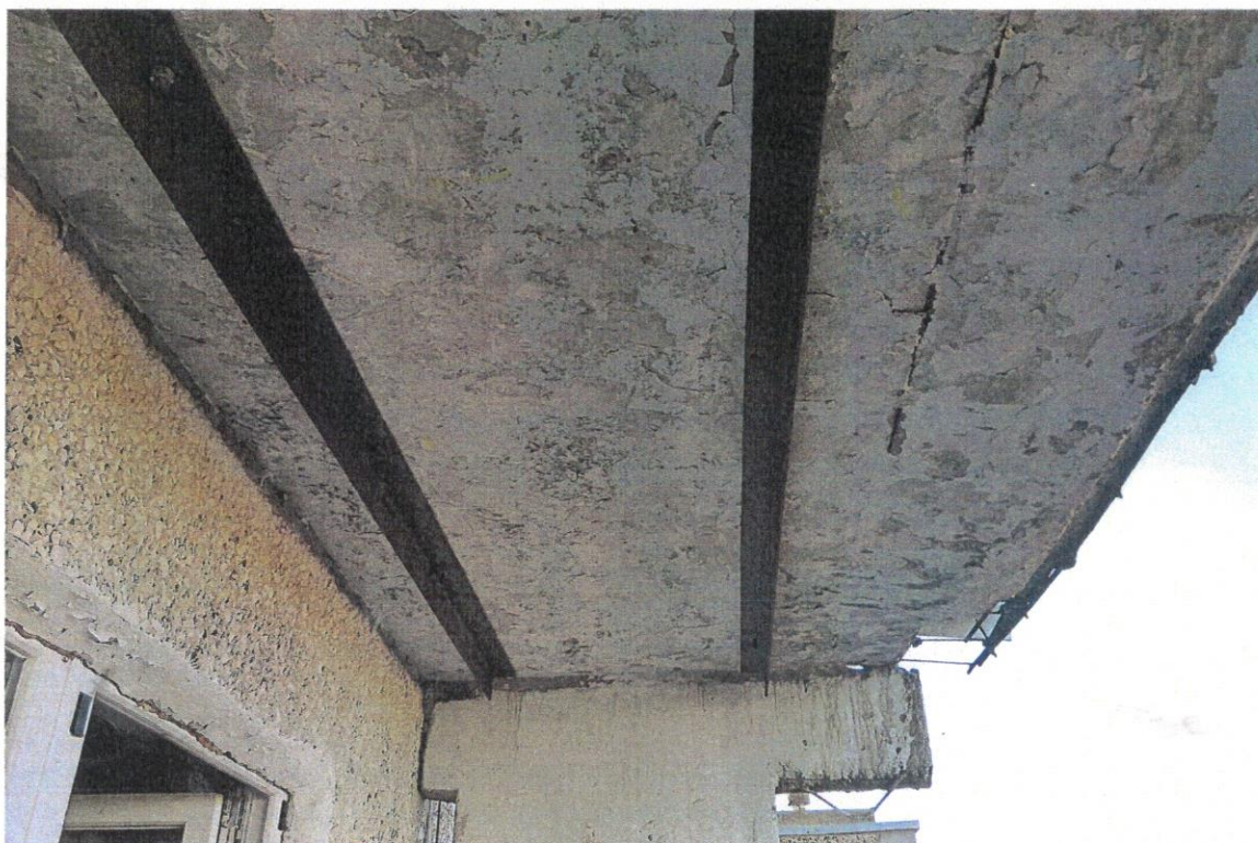
Pav. 4. Denginio plokštės suirimo ir ankstesnio tvirtinimo vaizdas
