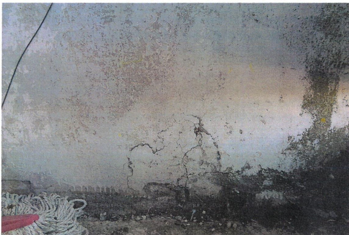
Pav. 6. Vertikalios laikančiosios plokštės rėmimo apačioje pažaidų vaizdas
