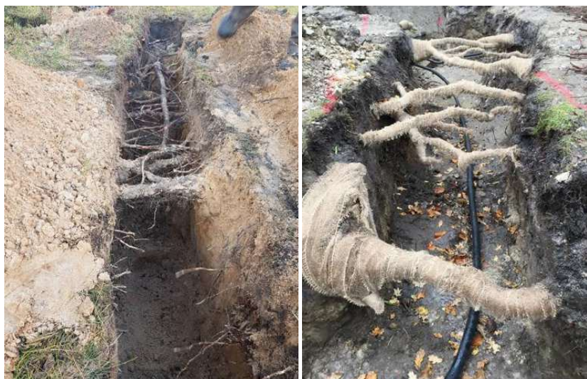
Pav. 9. Teigiami darbų pavyzdžiai - darbai atlikti teisingai, Medžio šaknų atkasimą oro kastuvu, taip išsaugomos smulkios ir medžiui svarbios šaknys, sudaromos sąlygos medžiui tarpti ir prisitaikyti prie pakitusių aplinkos sąlygų.
