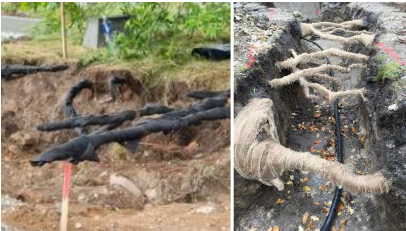
Pav. 7. Šaknų apgaubimas geotekstile, vykdant darbus.
