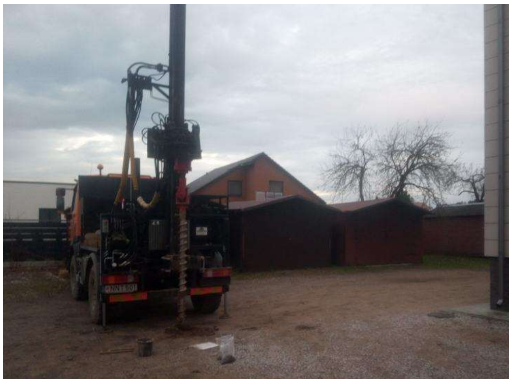
1 pav. Lauko darbai
