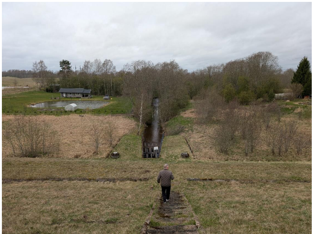
Vaizdas į žemutinį šlaitą, ištekėjimą ir nutekėjimo kanalą
