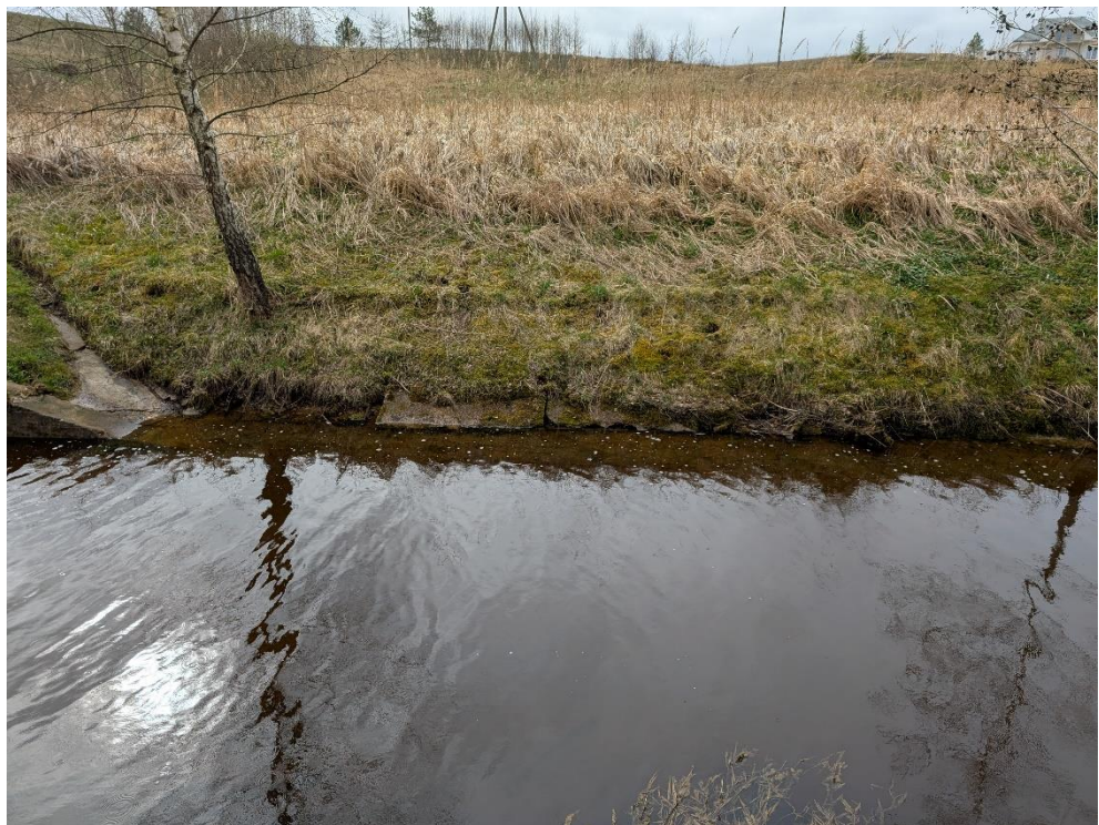
Ribermos gelžbetoniniai tvirtinimai
