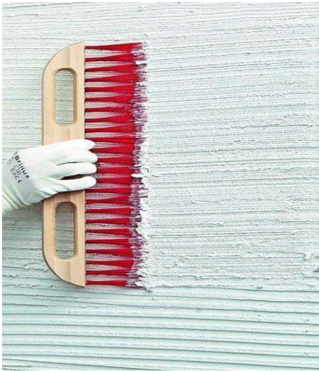
Betono šiurkštinimo įrengimo pavyzdys bei analogas.
