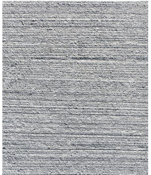
Betono šiurkštinimo įrengimo pavyzdys bei analogas.
