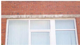
Pažeistų sąramų remontas
