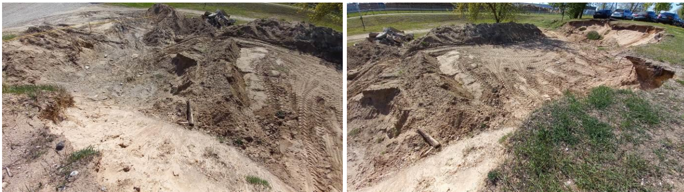
4 pav. Nukasta zona (plotas Nr. 2) po požeminių NP talpų pašalinimo (vaizdas iš šiaurės pusės)
