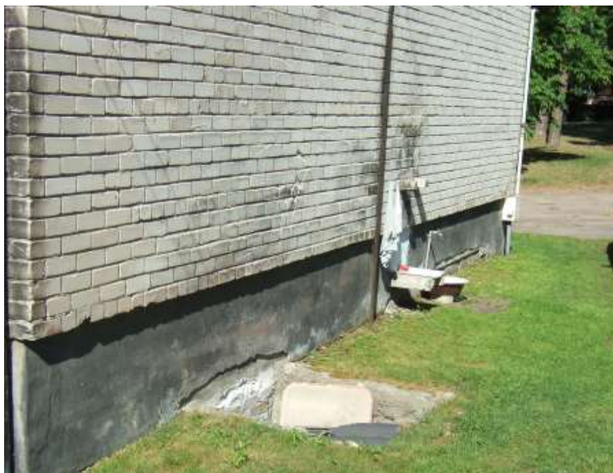
8 pav. Pastato nuogrindos ir atmūrijamas/atidengiamas langas rūšio langais, su prie duobe ir laistymo čiaupas fragmentas
