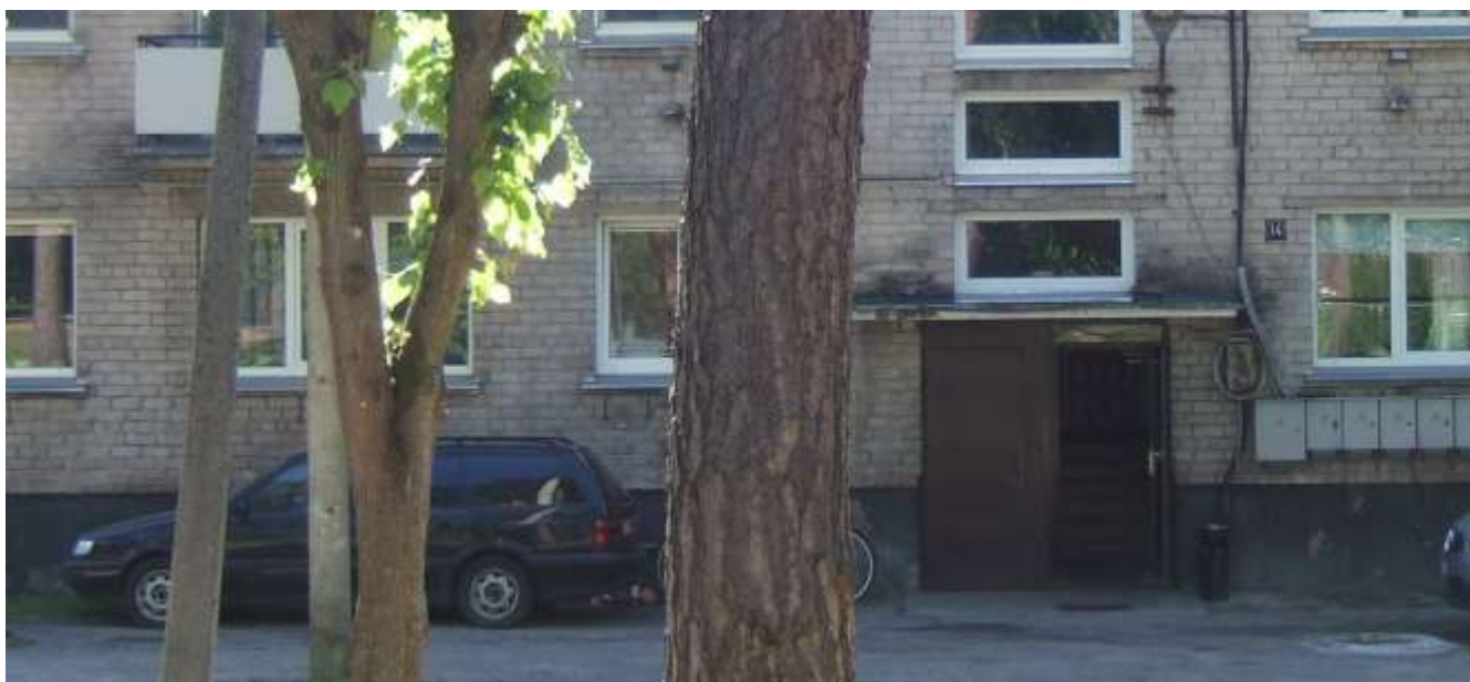
9 pav. Pastato nuogrindos, pamatų ir palangių, įėjimo fragmentas, butų apskaitos
