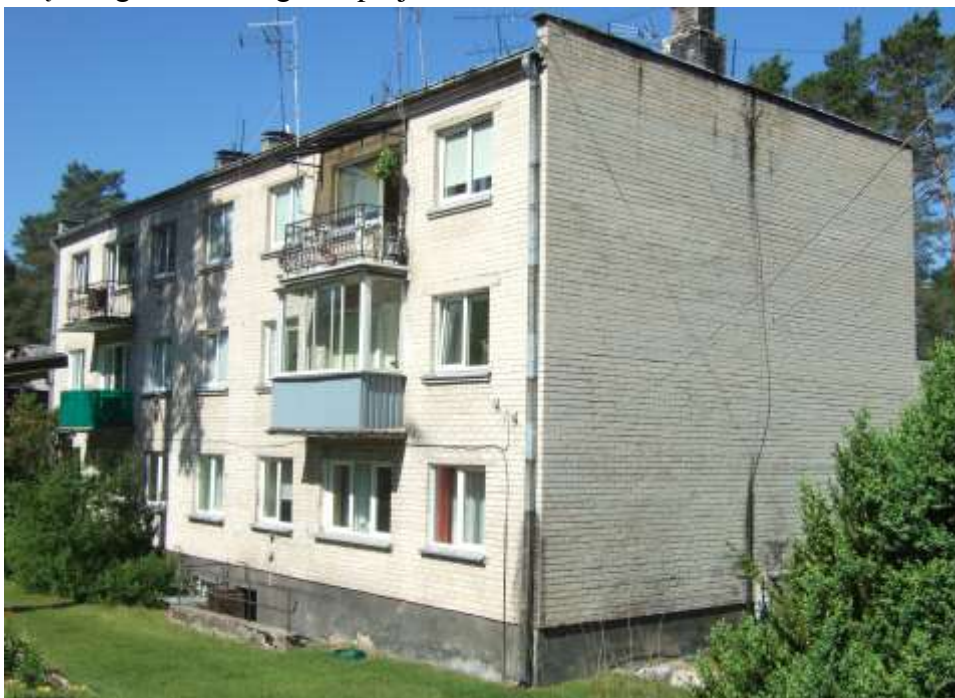
11 pav. Pastato fasado fragmentas, įėjimas į rūšį iš kiemo pusės (į buvusią katilinę)
