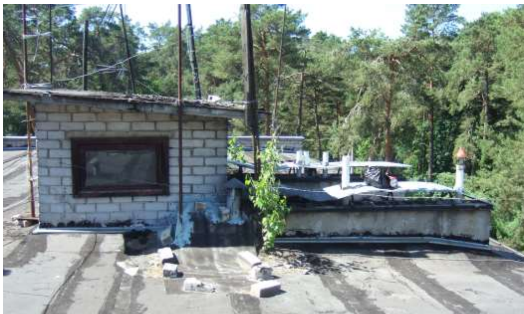
12. pav. Pastato stogo (tūrinis išlipimas, alsuokis, venšachta) fragmentas
