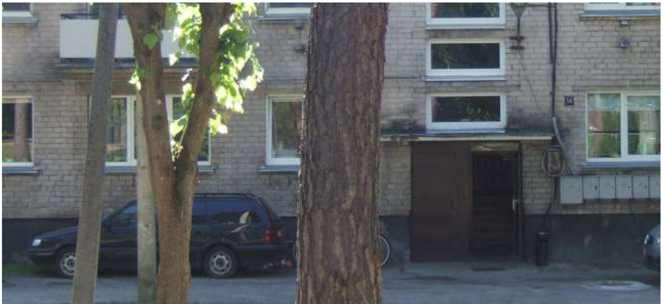
6. pav. Pastato nuogrindos, pamatų ir palangių, įėjimo fragmentas, butų apskaitos
