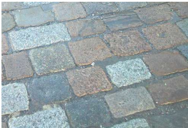
Lygaus paviršiaus tašyto lauko akmens grindinio dangos pavyzdys.
