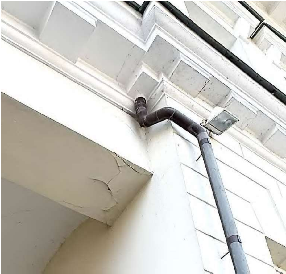
3 FF. Balkonas tarp ašių 1-2. Lietvamzdžio prie balkono karnizo fragmentas. Rygelyje ir skliaute matosi įtrūkimai.
