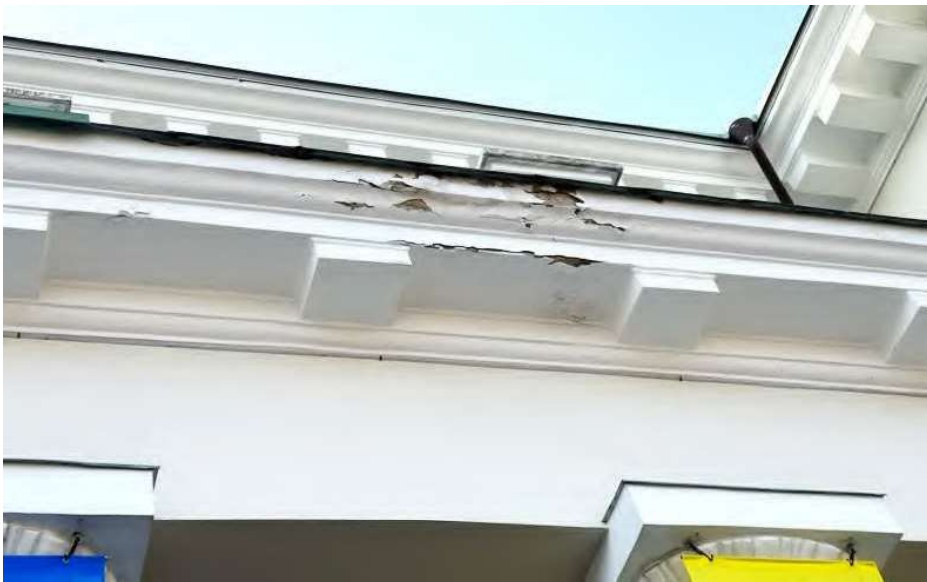
4 FF. Balkonas tarp 1-2 ašių. Karnizo fragmentas defektai.
