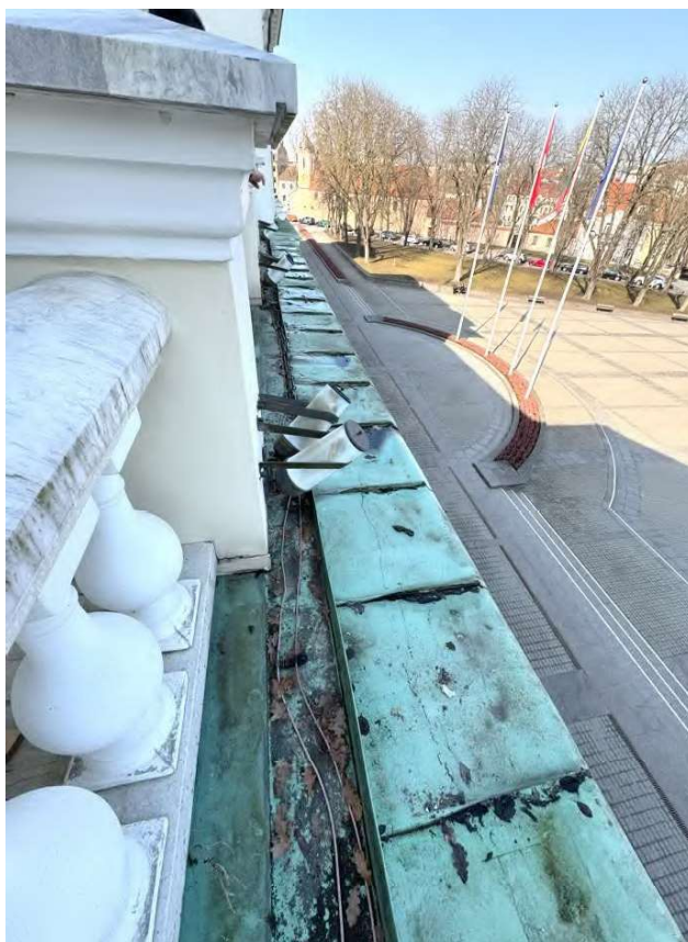
9 FF. Balkonų karnizų apskardinimas ir kritulių nuvedimo latakas nuo balkonų su šildymo laidais. Krituliai nuo latakų suvesti į lietvamzdžius, nuo karnizų kritulių nuvedimas neįrengtas.
