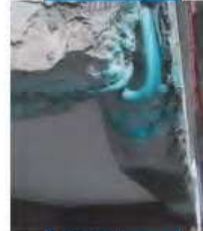
Prickinės baftono- dalis armatūra spūvota Mapefer 1K
