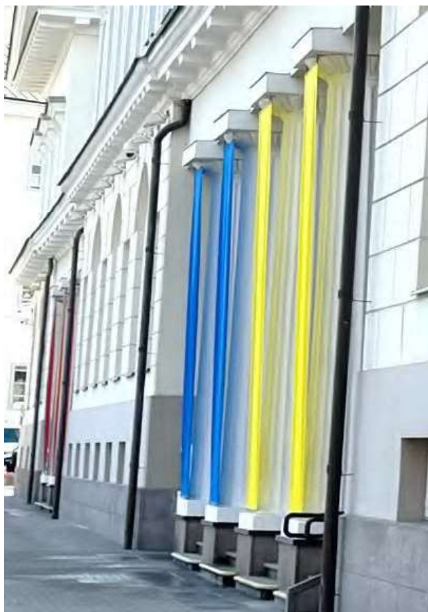
6 FF. Balkonų tarp 1-2 ir 3-4 ašių bendras vaizdas su kritulių nuvedimo nuo balkonų lietvamzdžiais (4 vnt.) Aikštės danga po balkono karnizu pastoviai šlampa.
