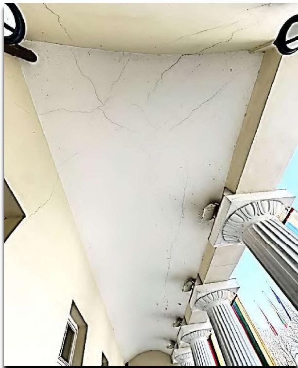
5 FF. Balkono tarp ašių 1-2 skliauto defektai – išilginiai įtrūkimai.
