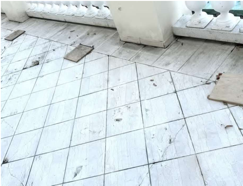
11 FF. Marmurinės plytelių dangos defektai.
