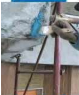
Mapefer 1K tepamas teptuku ant atvirų balikono armatūros strypų
