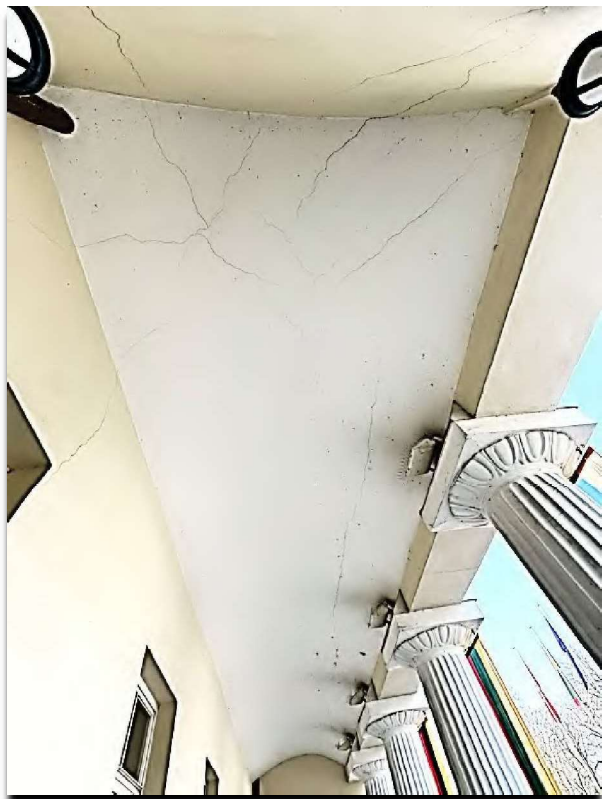
7 FF. Balkono tarp 3-4 ašių skliautų ir sienų defektai.
