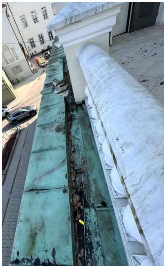
9 FF. Balkonų karnizų apskardinimas ir kritulių nuvedimo latakas nuo balkonų su šildymo laidais. Krituliai nuo latakų suvesti į lietvamzdžius, nuo karnizų kritulių nuvedimas neįrengtas.
