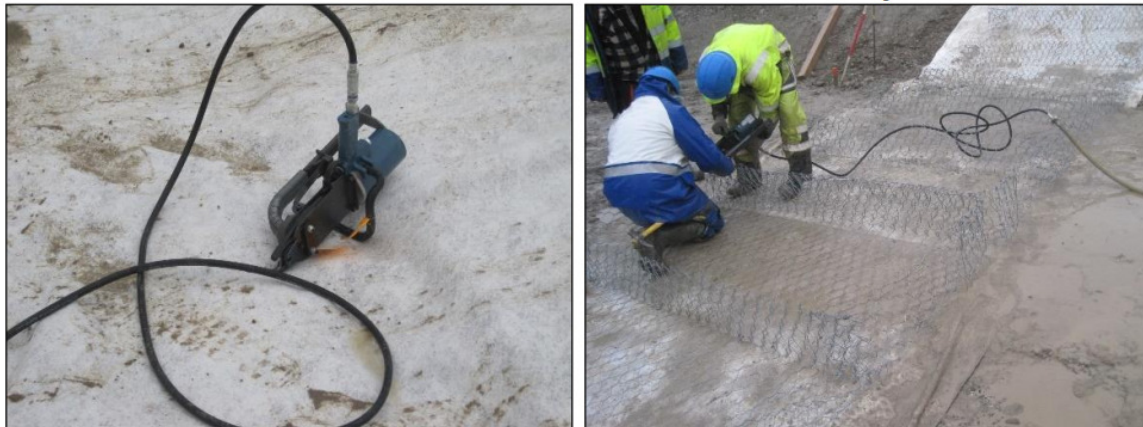
6 pav. – Pneumatinių žiedų užspaudimo replių naudojimas.
