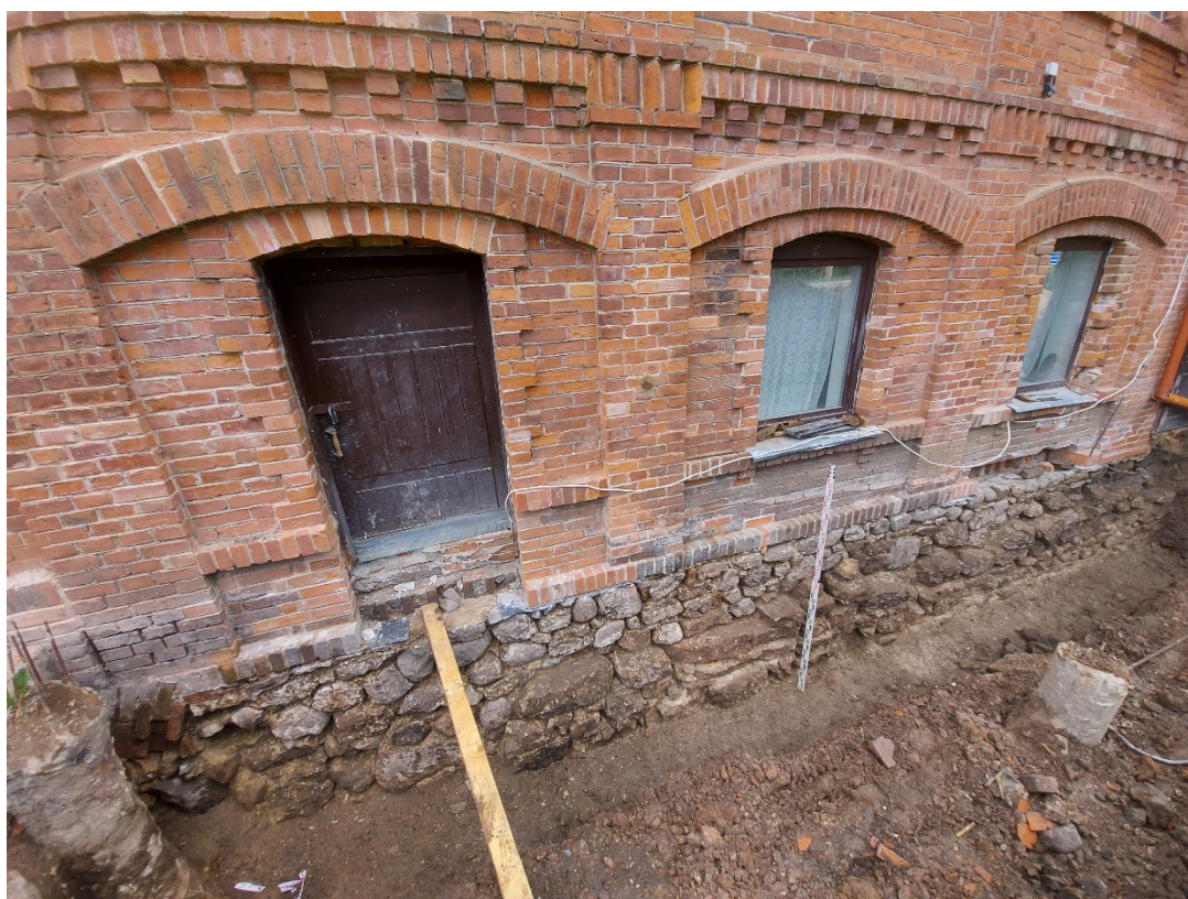
Atkastų pamatų 13 – 24 metruose vaizdas (fotografuota iš PR)
