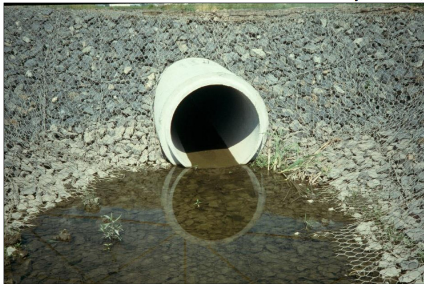
14 pav. – Gabionų matrasą kertantis vamzdis
