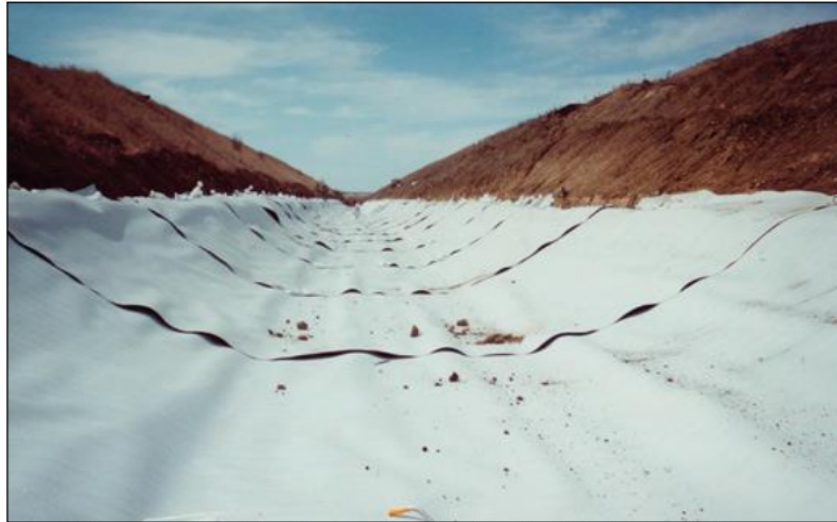
10 pav. – Geotekstilės su skersiniais persidengimais klojimas
