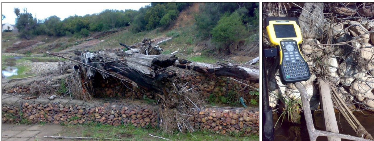
16 pav. – Gabionų matrasų defektai dėl upe nešamų medžių.
