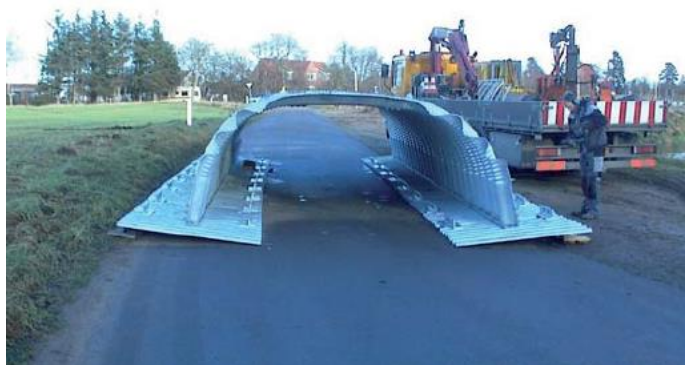
5 pav. Plieniniai gofruoti pamatai
