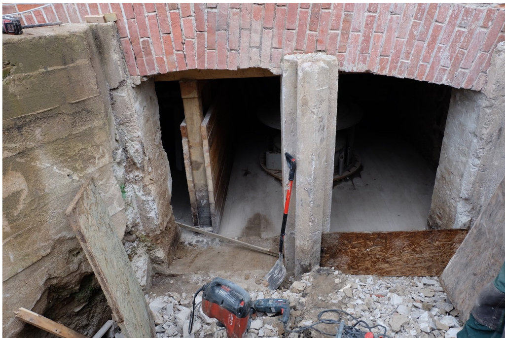
Vandens padavimo latakas prie malūno sienos. Atvertos buvusios užmūrytos angos į turbinų kanerą.
