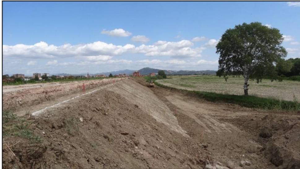
7 pav. Gabionų matrasų pagrindo išlyginimas.
