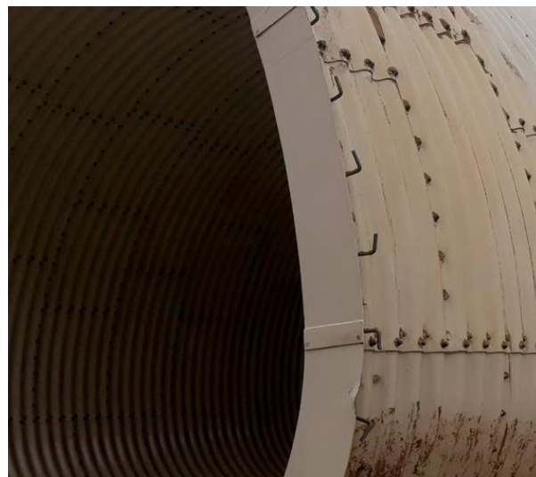
8 pav. Konstrukcijos galuose įrengiamas apvadas
