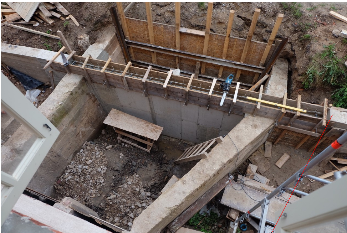
Vandens padavimo latakas zonoje tarp malūno pastato ir kelio (kelio atraminės sienutės įrengimo metu).
