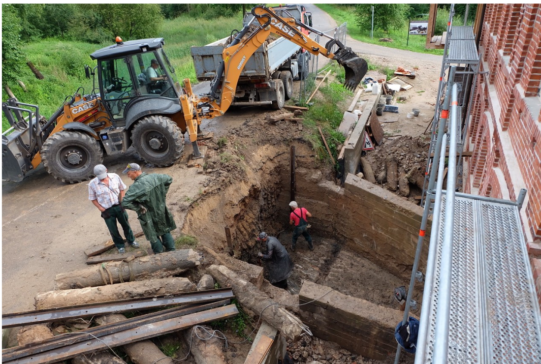
Atkastas vandens padavimo latakas prie malūno sienos kelio atraminės sienutės įrengimo metu.
