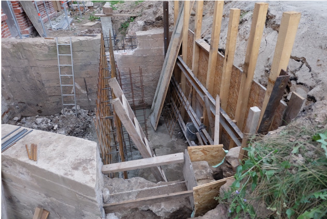
Tvarkybos darbų metu atidengtas vandens padavimo latakas tarp tarp malūno sienos ir kelio
