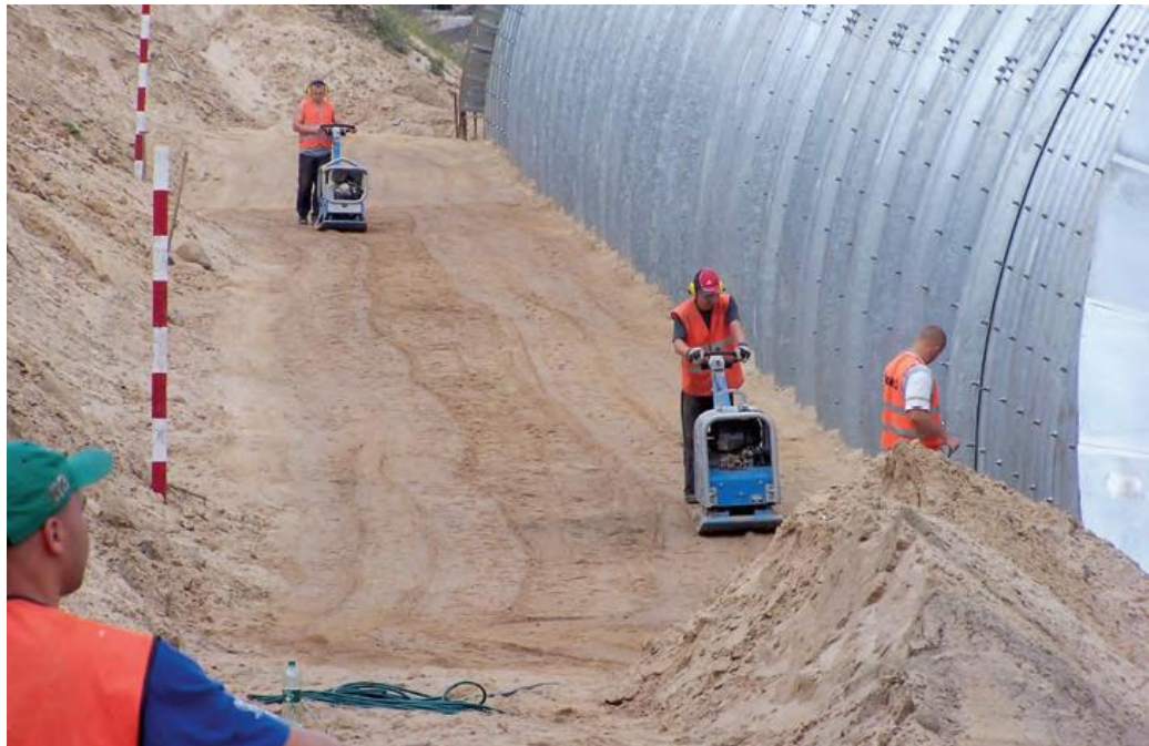
10 pav. Grunto užpylimas ir sutankinimas
