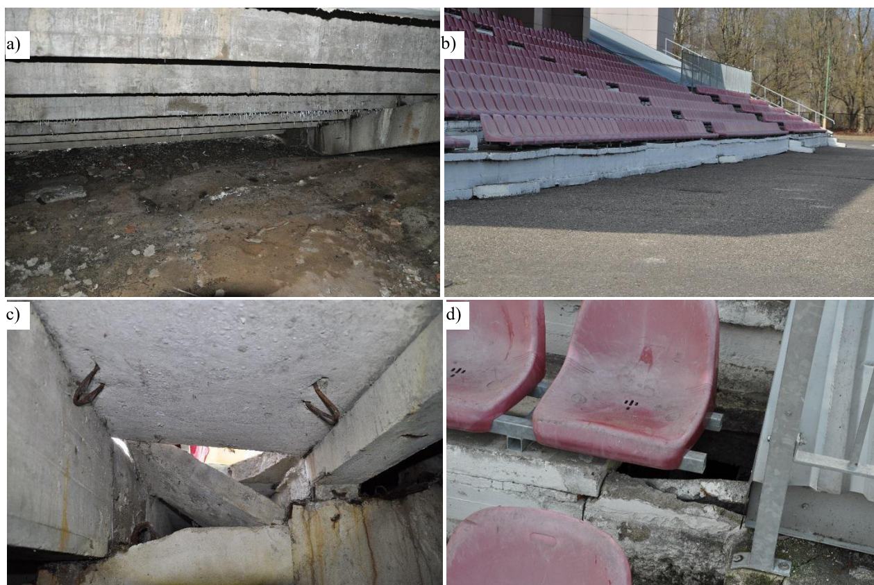
2.6 pav. Tribūnų denginio plokščių pažaidų vaizdai
