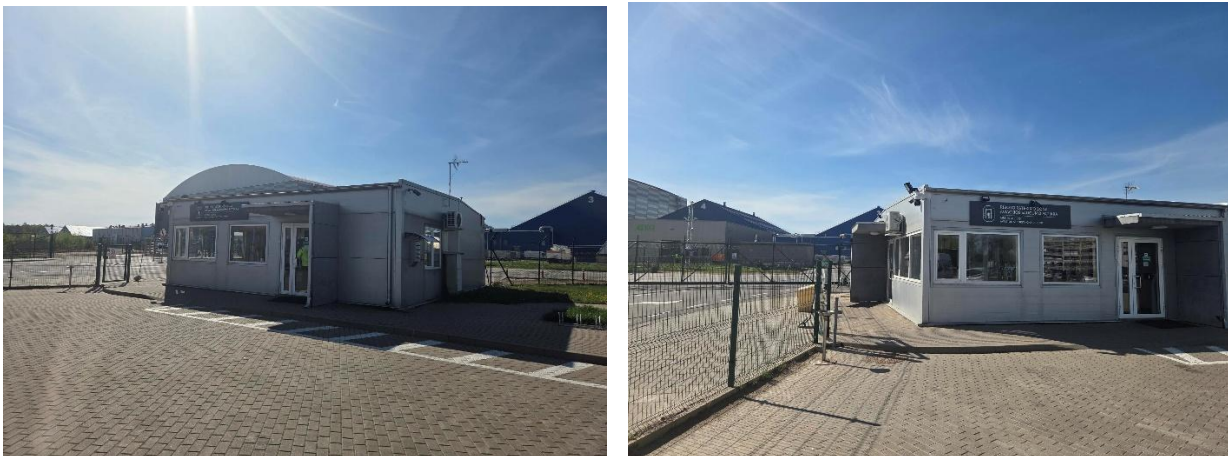
2 pav. Esamas kontrolės patikros postas (KPP).
