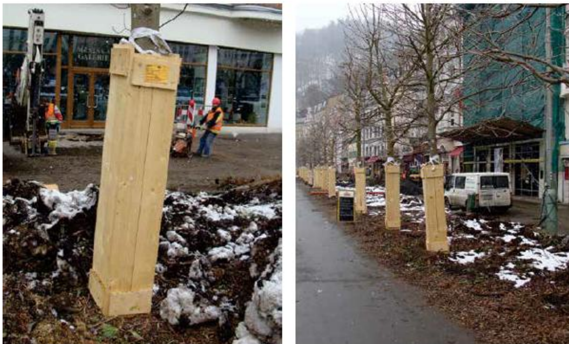
4. Pav. Galima medžių kamienų apsauga vykdant darbus
