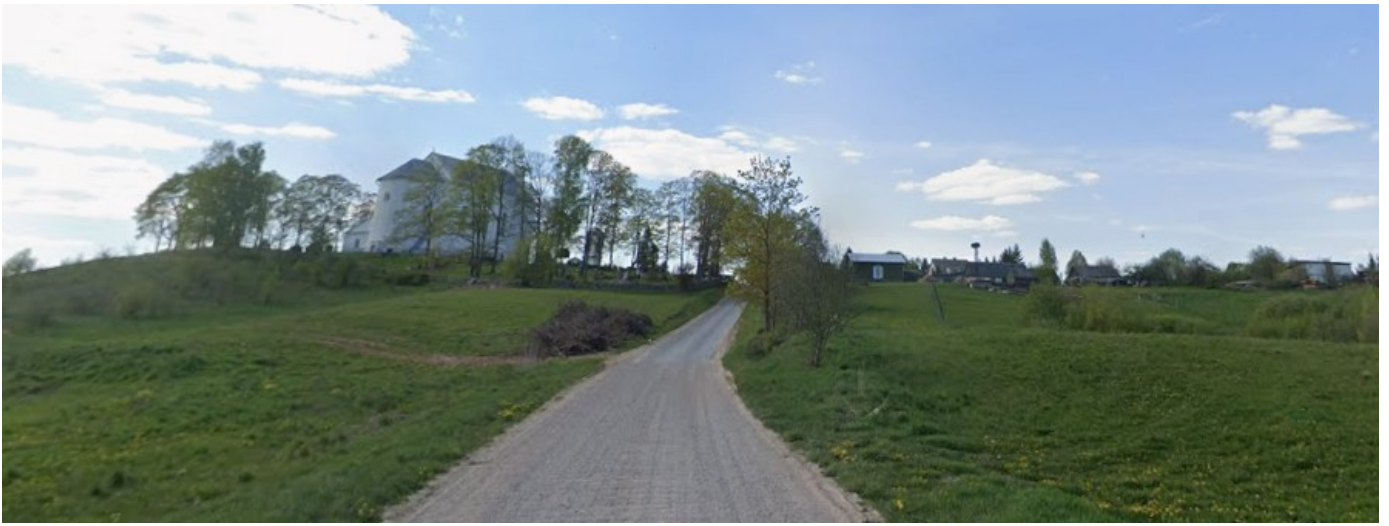
2 pav. Esama kelio būklė (kelio ruožo pradžia)
