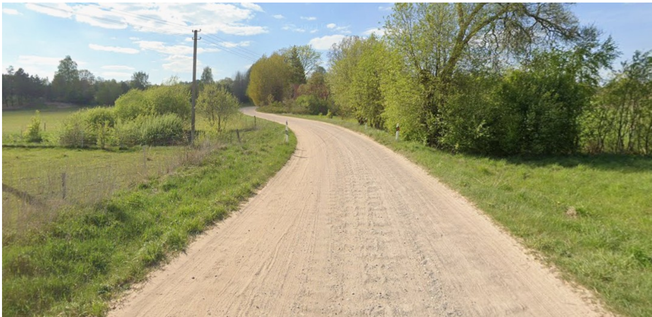
5 pav. Esama kelio būklė
