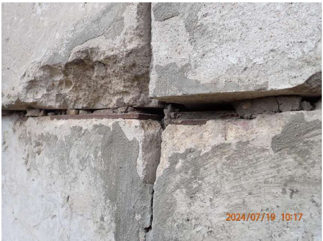
Nuotrauka Nr. 2. Nuskilę tvoros plokščių kampai, įdėtinės tvirtinimo detalės tik tvoros plokščių viršuje (apačioje nėra)
