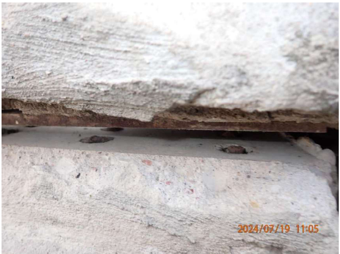
Nuotrauka Nr. 12. Atitrukusios nuo tvoros plokštės įdėtinės detalės vaizdas (kurios pagalba tvoros plokštė privirinama prie stulpų įdėtinių detalių)
