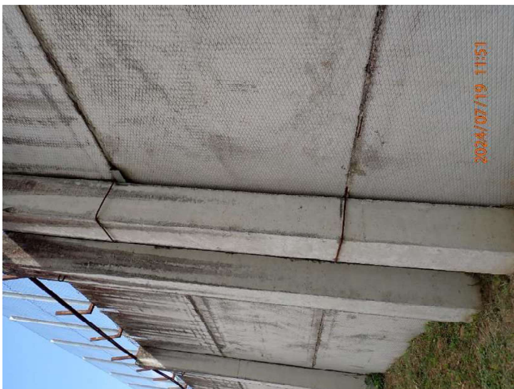
Nuotrauka Nr. 16. Atliktas papildomas plokščių tvirtinimas
