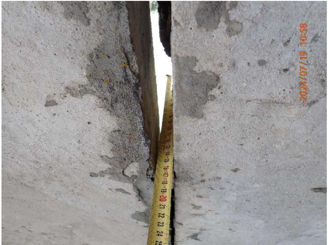
Nuotrauka Nr. 11. Atitrukus tvoros tvirtinimo įdėtinei detalei nusėdusi plokštė, ištrupėjęs užpildo cementinis skiedinys
