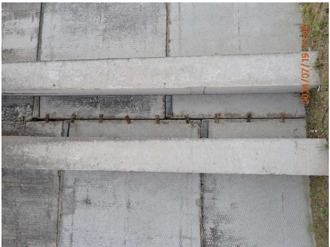
Nuotrauka Nr. 14. Bendras maskuojamosios tvoros vaizdas su deformacine siūle iš išorės pusės
