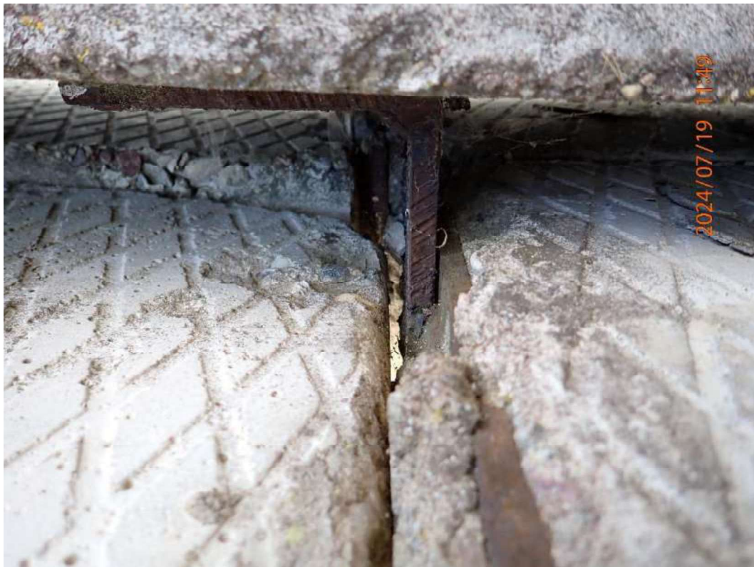
Nuotrauka Nr. 15. Tvoros plokščių tvirtinimo mazgo vaizdas (matosi, kad plokštės tvirtintos tik viršutinėje briaunoje, o viršutinės plokštės briauna sumontuota ant cementinio skiedinio ir įdėtinės detalės neturi)
