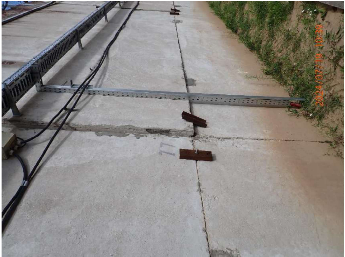
Nuotrauka Nr. 7. Poslinkiai tarp atskirų tvoros plokščių „bandyti suveržti“ metalo apkabomis. „Suveržimas“ dalinai sustabdo laisvą plokščių „plevėsavimą“.
