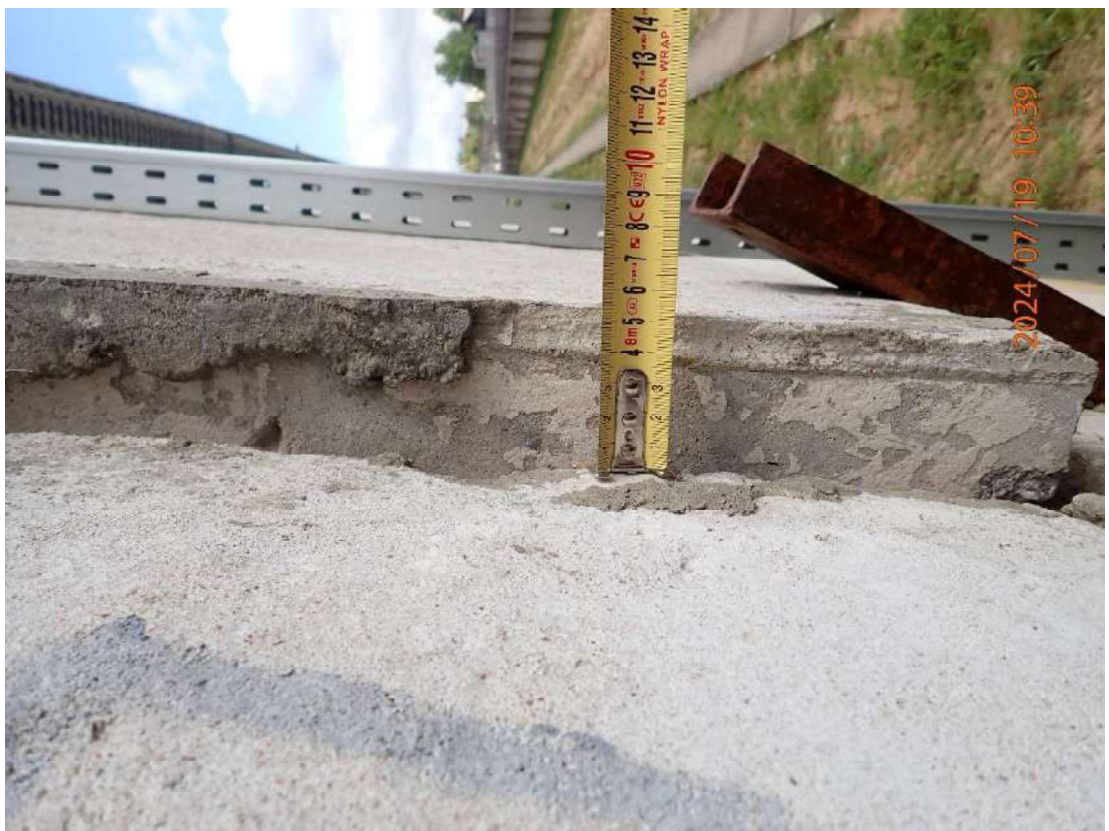
Nuotrauka Nr. 8. Tvoros plokščių poslinkiai „iš tvoros plokštumos“ viršija 5cm
