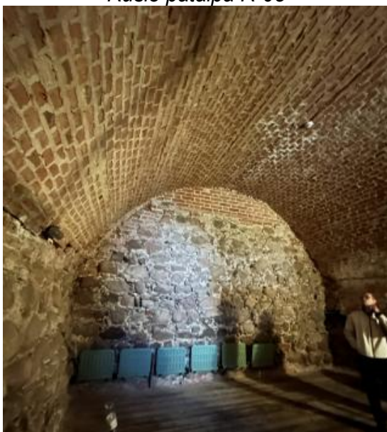
Rūsio patalpa R-06
