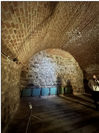
Patalpos R-06 fotografacijos
