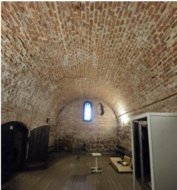
Rūsio patalpa R-05
