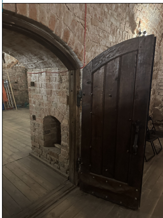
Praėjimo angos tarp R-04 ir R-05 patalpų fotofiksacija
