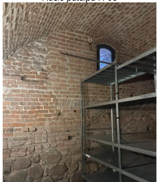
Rūsio patalpa R-06
