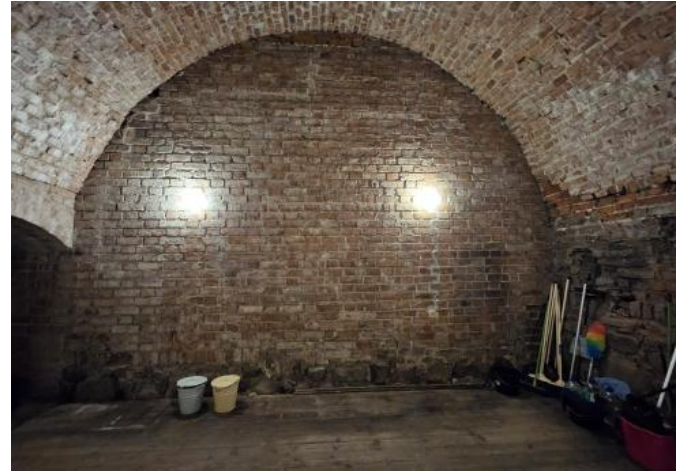
Rūsio patalpa R-04
