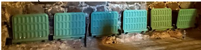
Radiatorių demontavimas
