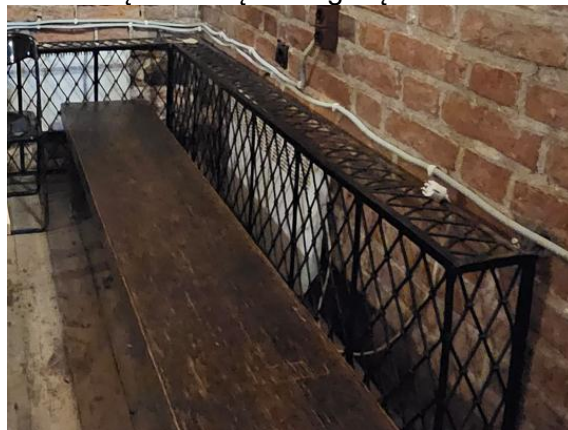
Radiatorių metalinių uždengimų demontavimas
