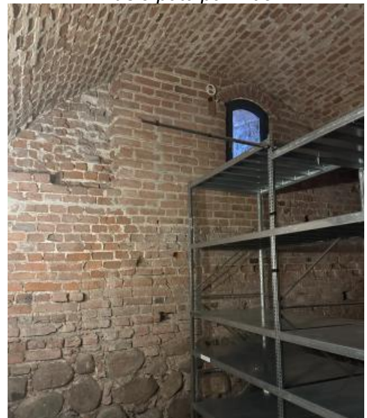
Rūsio patalpa R-06
