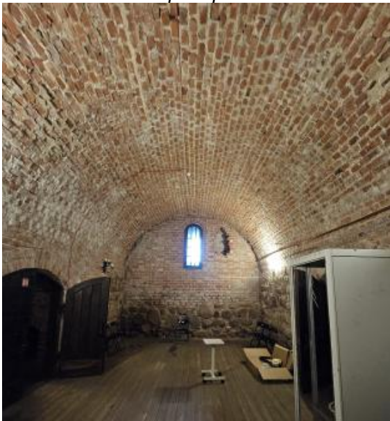
Rūsio patalpa R-05
