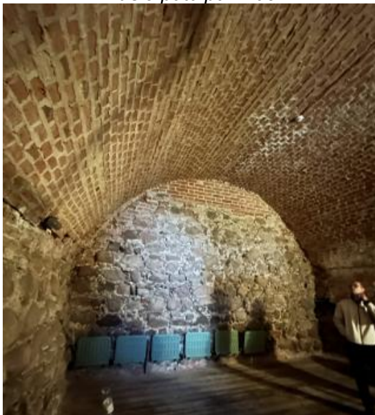
Rūsio patalpa R-06
