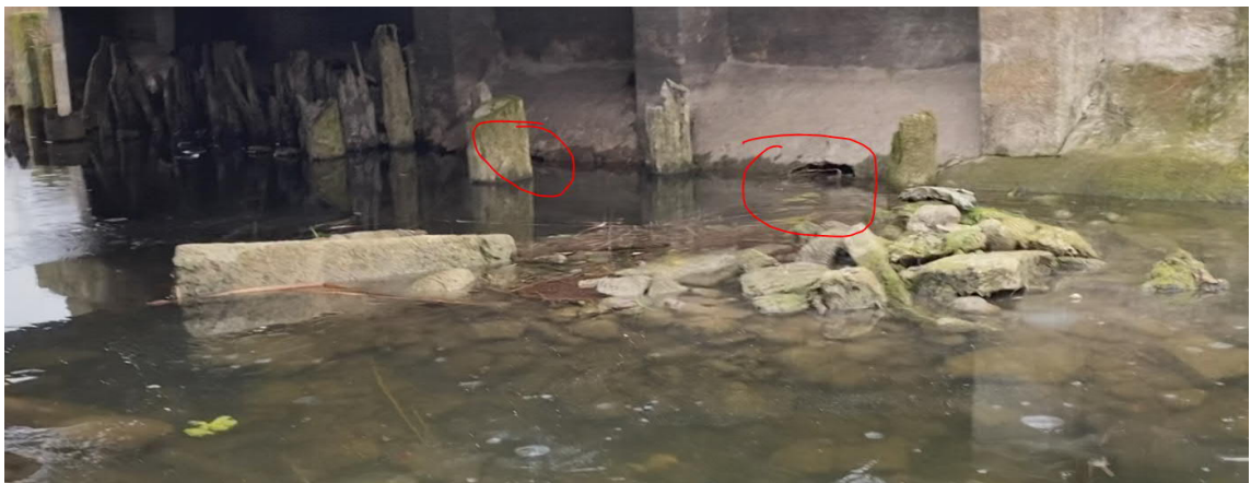
2.7.pav. Kanalo vaizdas nuo aukštupio pusės link antros atramos.
