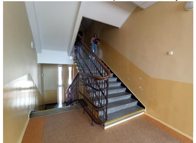
9. Evakavimosi iš palėpės kelias L1 tipo laiptine, kuri yra, 1,40 m pločio.
