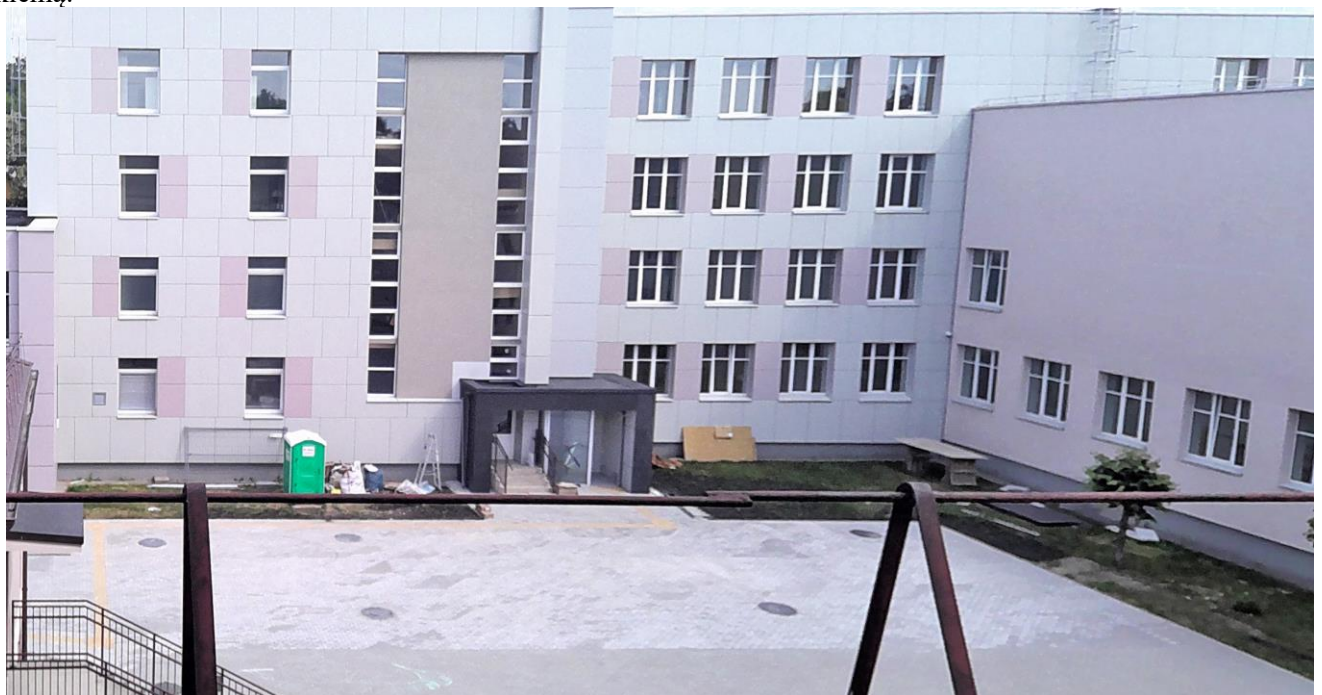
13. Vaizdas į vidinį mokyklos kiemą nuo remontuojamos palėpės šlaitinio stogo.
