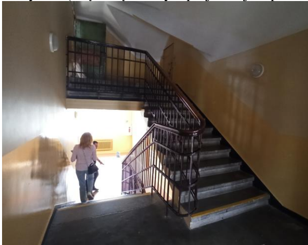
9. Evakavimosi iš palėpės kelias L1 tipo laiptine, kuri yra, 1,40 m pločio.
