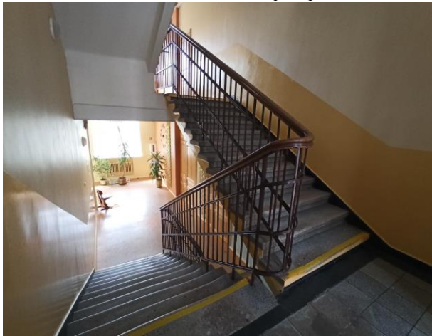
9. Evakavimosi iš palėpės kelias L1 tipo laiptine, kuri yra, 1,40 m pločio.
