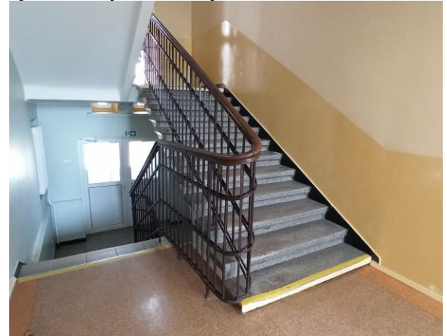
9. Evakavimosi iš palėpės kelias L1 tipo laiptine, kuri yra, 1,40 m pločio.
