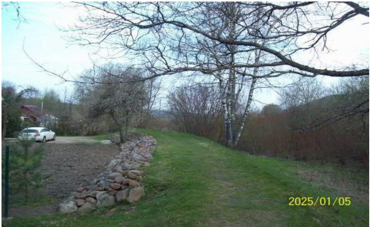
18 pav. Sodininkai savarankiškai akmenų metiniu tvirtina pylimo šlaitą.
