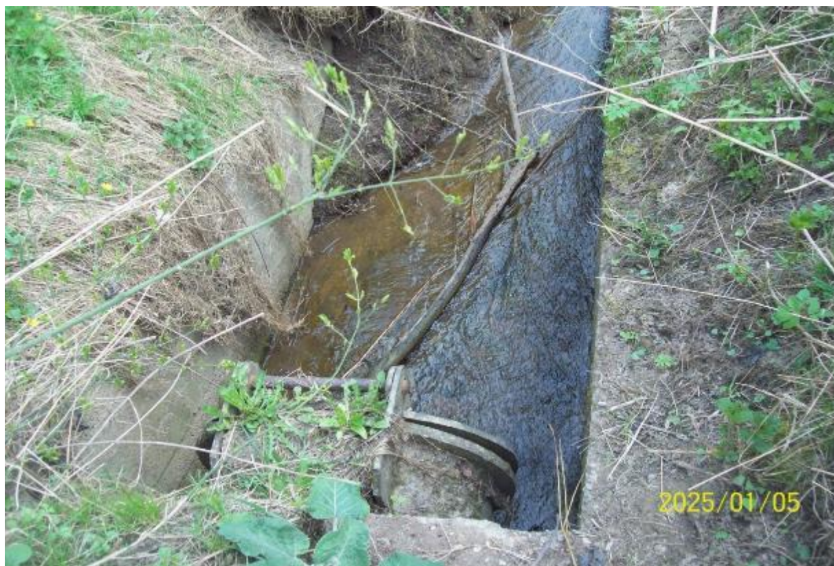
6 pav. Vanduo iš pelkės dalinai išbėga į Miniją per vamzdinę pralaidą su atbuliniu vožtuvu.
