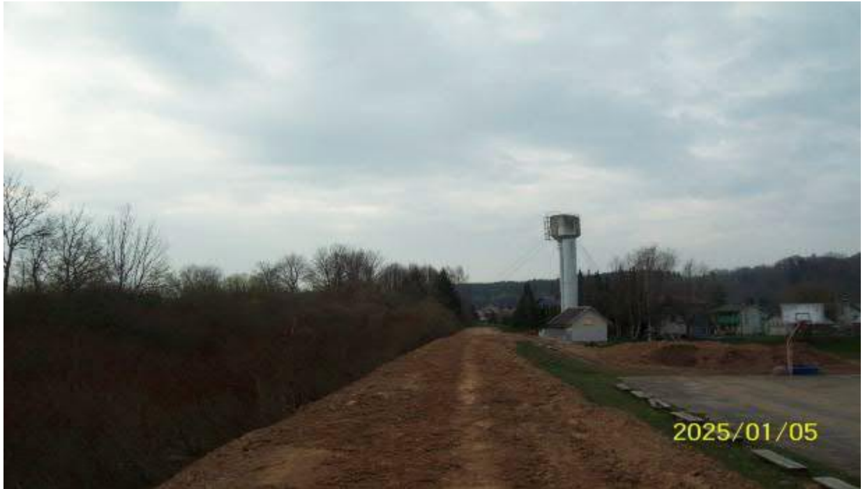
16 pav. Savavališkai remontuojamas potvynio metu išplautas pylimas, pilant gruntą ant krūmų..
