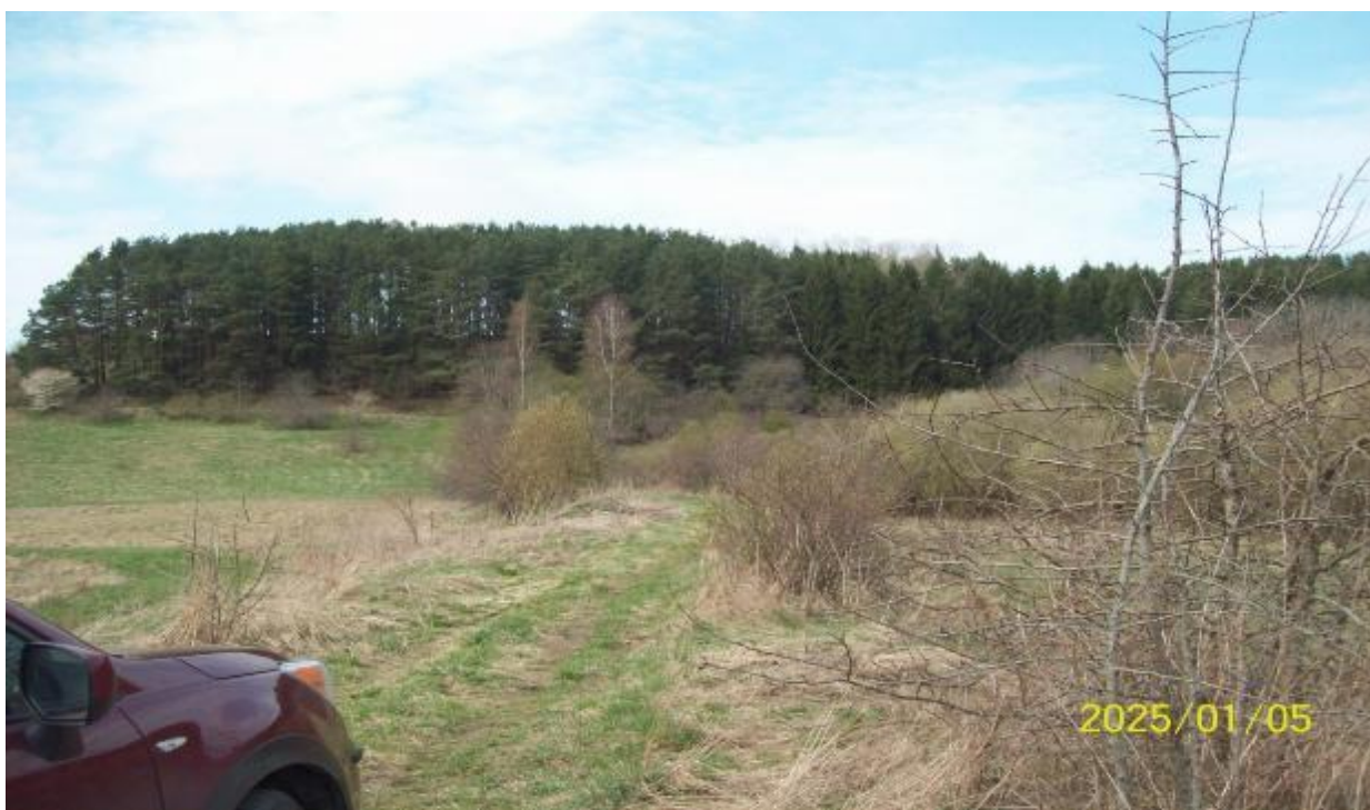
3 pav. Pylimas (damba) neprižiūrima, auga žolinė augmenija ir krūmai. Kartenos miestelio prieigose pagal Minijos tėkmę.
