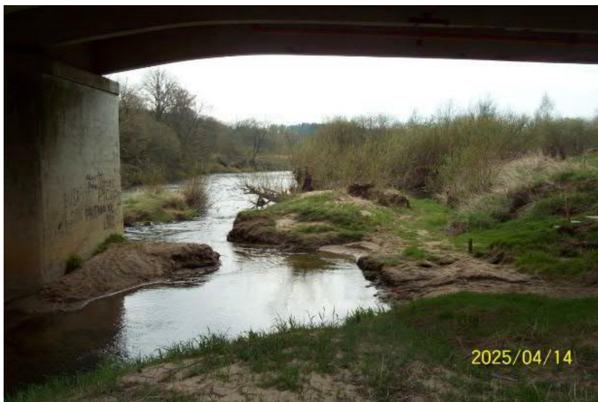
13 pav. Vandens pralaidumui padidinti Minijos vagoje už tilto rekomenduojame pašalinti nešmenų susiformavusias salas. Padidėjęs vandens pralaidumas po tiltu sumažins užliejamus prie miestelio plotus.
