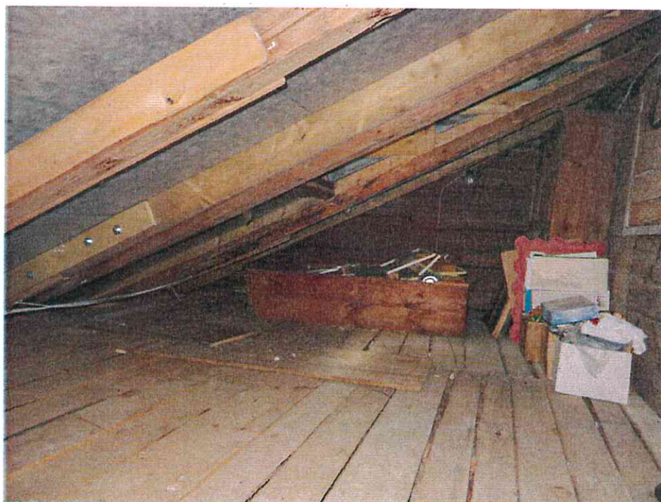
10. Stogo remonto metu įrengta nauja stogo danga, gegnės sustiprintos antdeklais.
