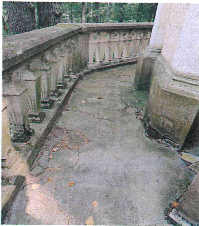
16. Cementinis užtepas sutrūkinėjęs ir atšokęs nuo pagrindo.
