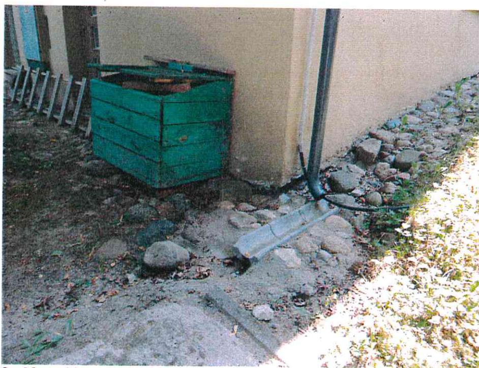
2. Netvarkinga nuogrinda, nerišlūs pavieniai akmenys.
