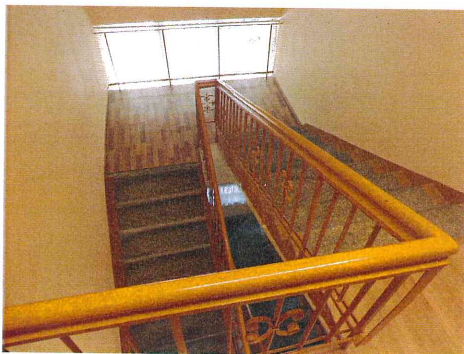
6. Laiptinė mūrinėje dalyje surenkamų teracinių pakopų ant metalinių laiptasijų.
