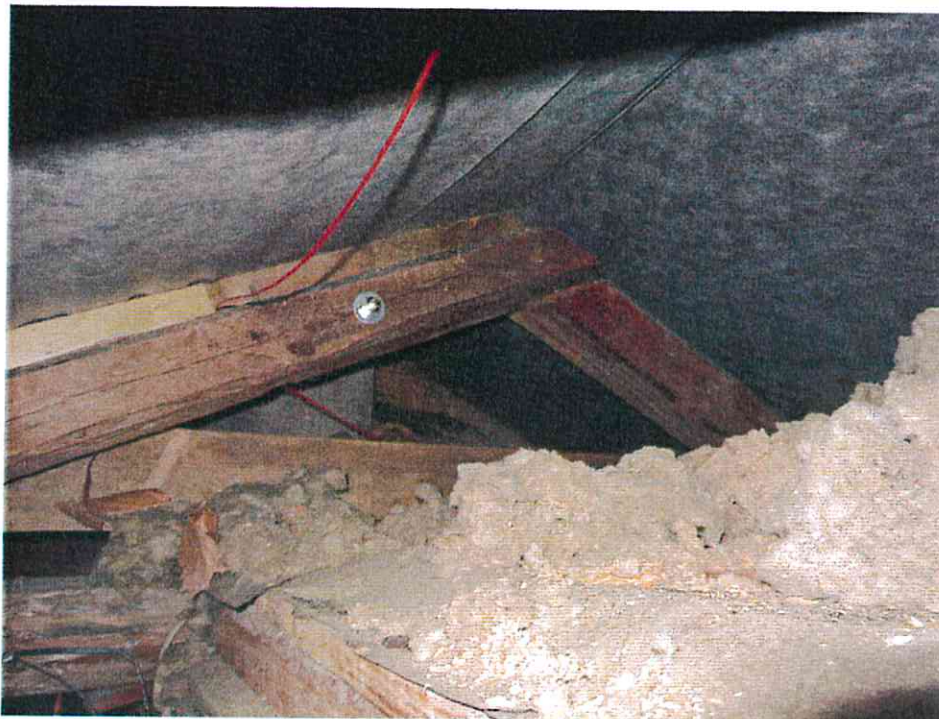
11. Mansardos perdanga apšiltinta šlako užpildu ir 100 mm akmens vata.
