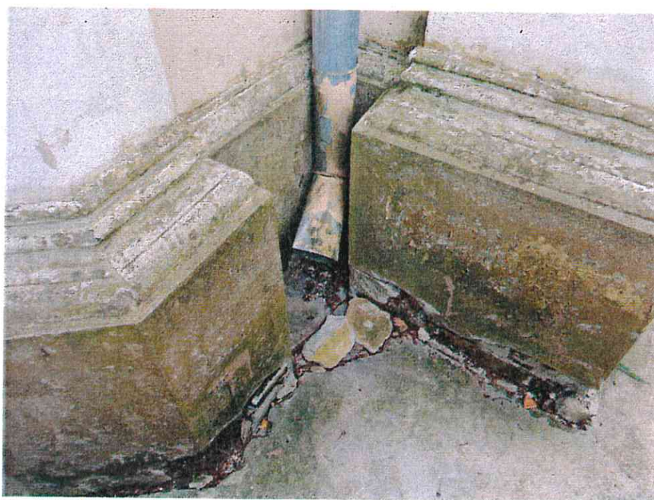
14. Kritulių nuvedimas nenuvestas nuo pastato, lietvamzdžiai deformuoti.
