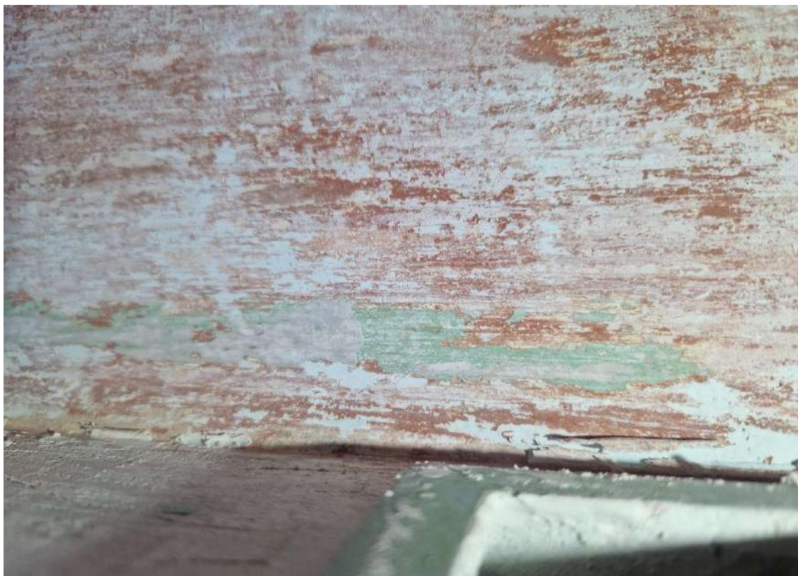
Patalpa 1-11. Tyrinėjama lubų zona Nr. 1 Plokštuma 8.
