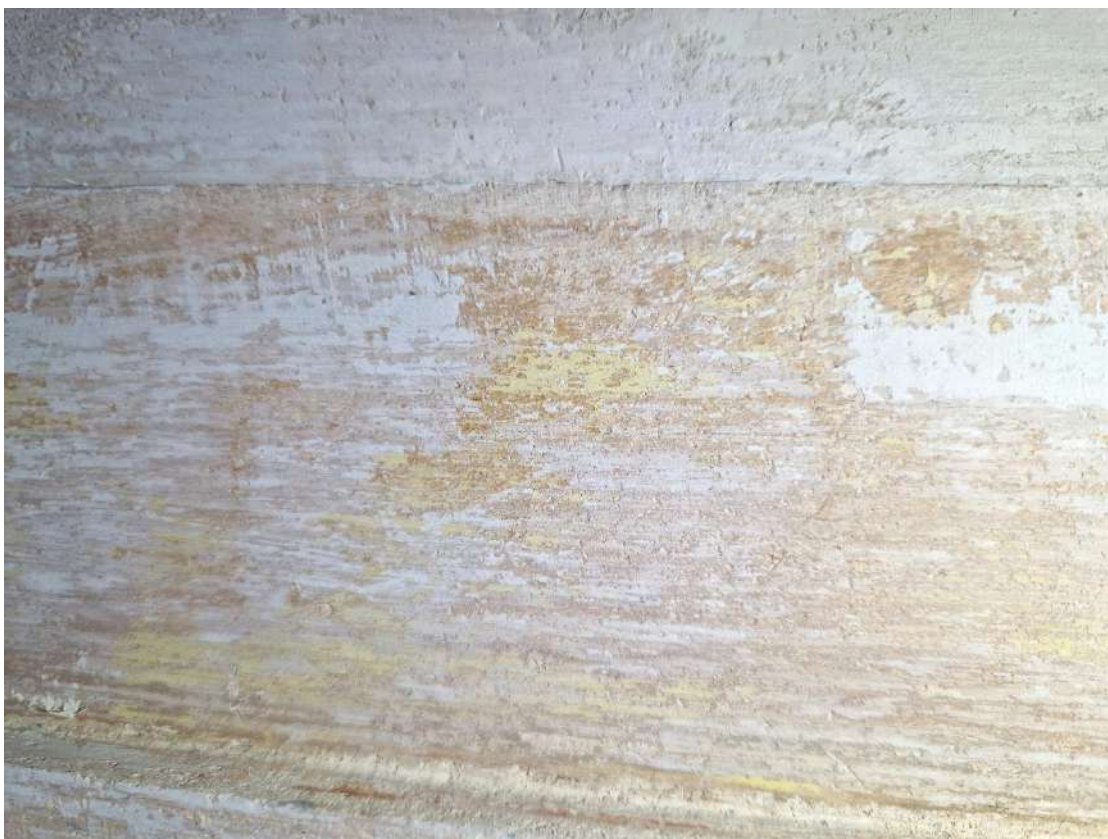
Patalpa 1-11. Tyrinėjama lubų zona Nr. 1 Plokštuma 10.
