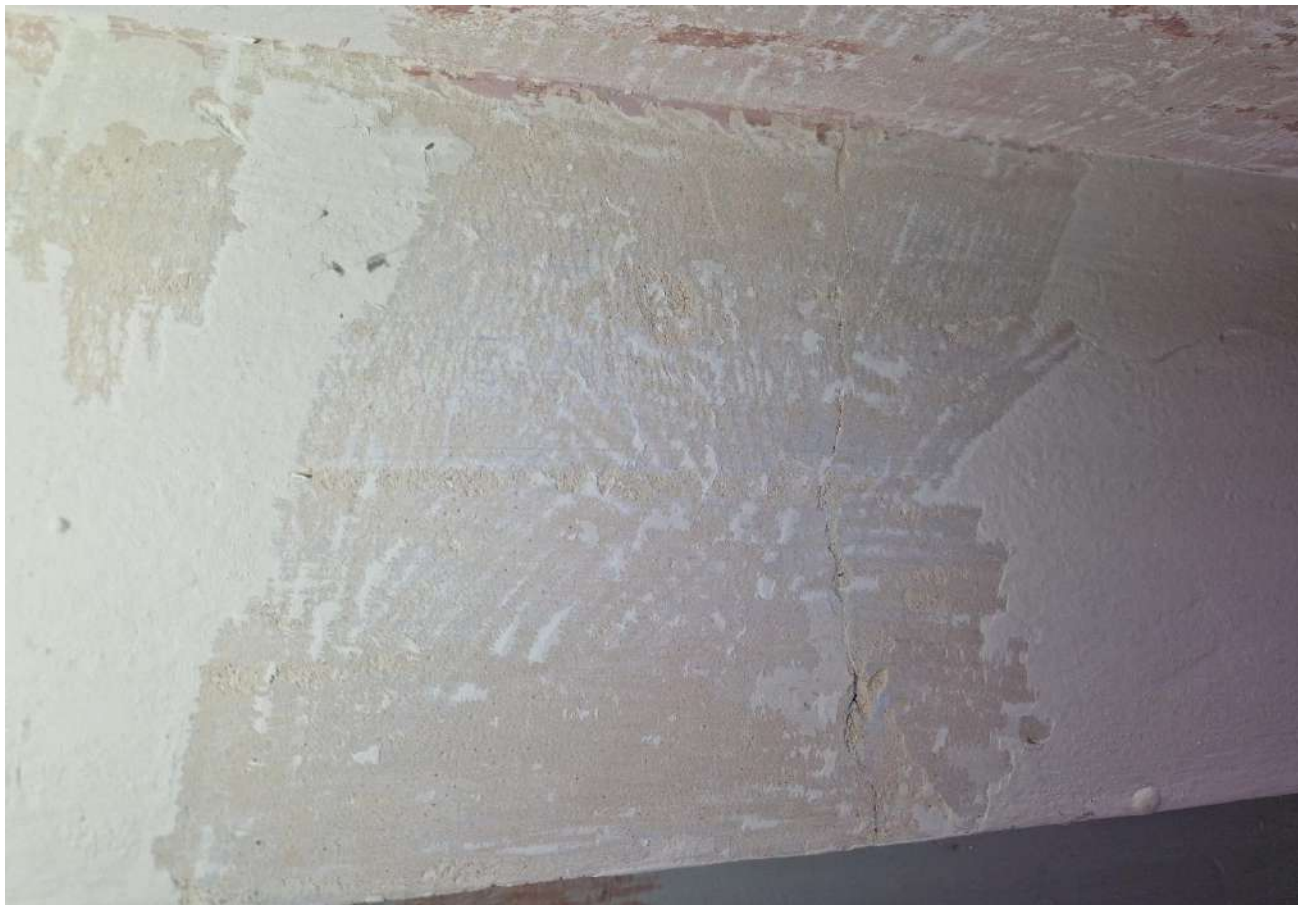
Patalpa 1-11. Tyrinėjama lubų zona Nr. 3. Plokštuma 7.
