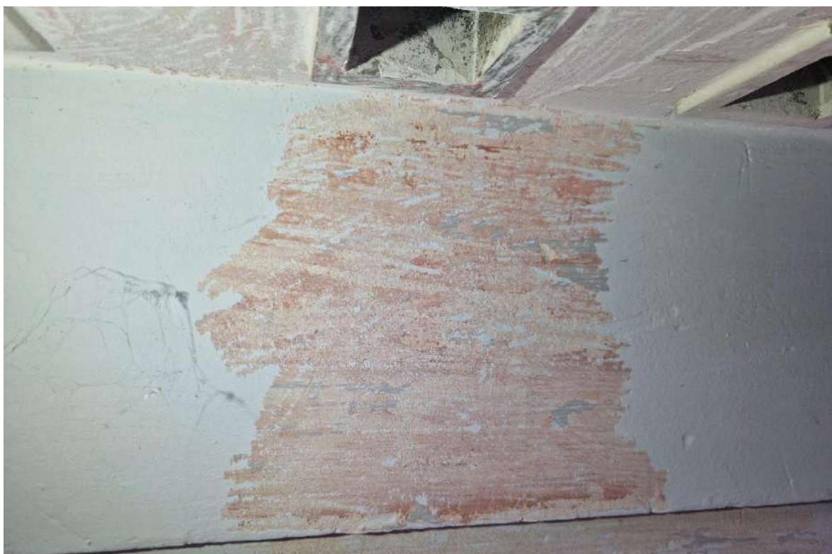
Patalpa 1-11. Tyrinėjama lubų zona Nr. 3. Plokštuma 8.
