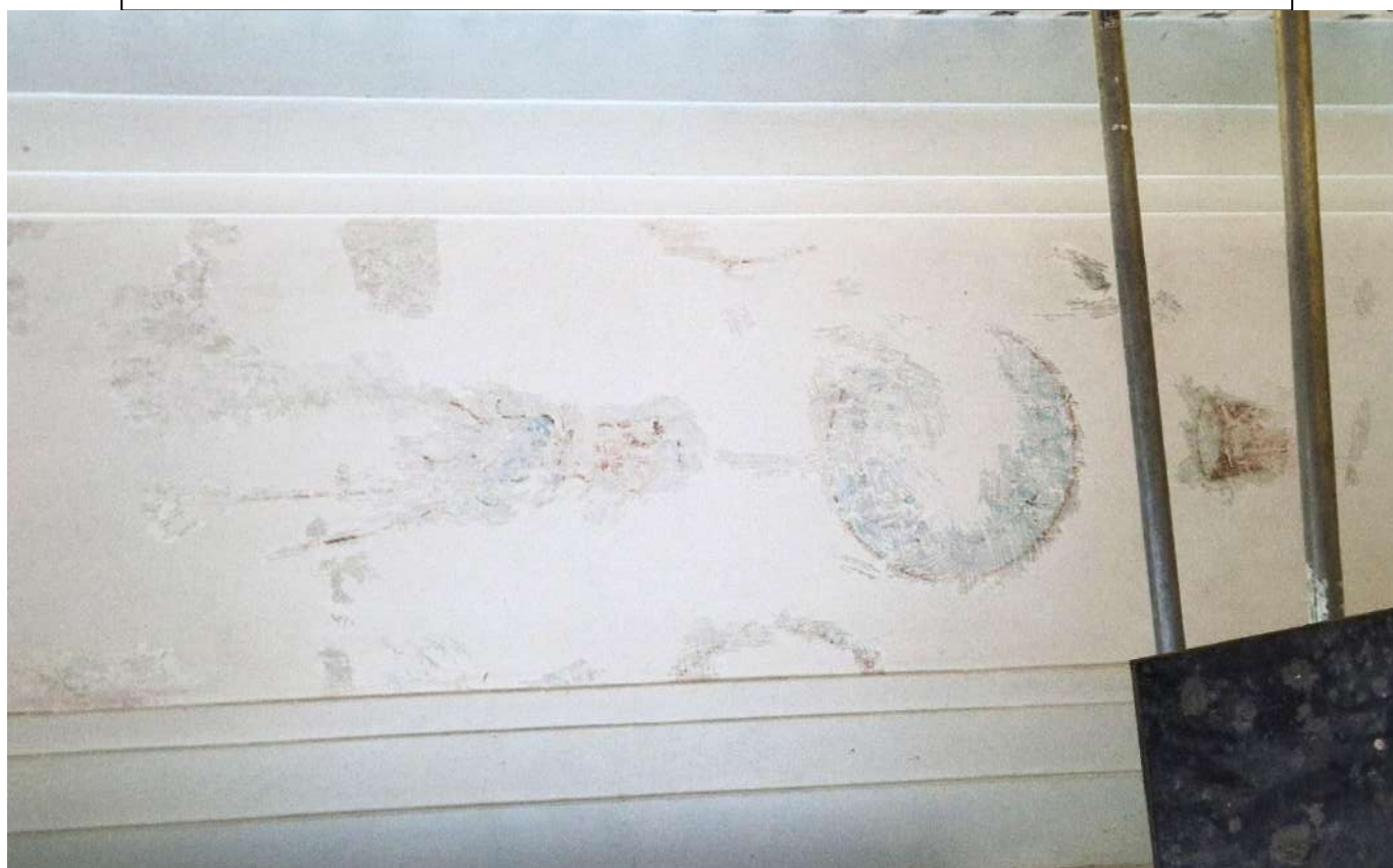
Patalpa 1-11. Tyrinėjama lubų zona Nr. 4. Kiek įmanoma, išsiaiškintas autentiškas dekoru motyvas.
