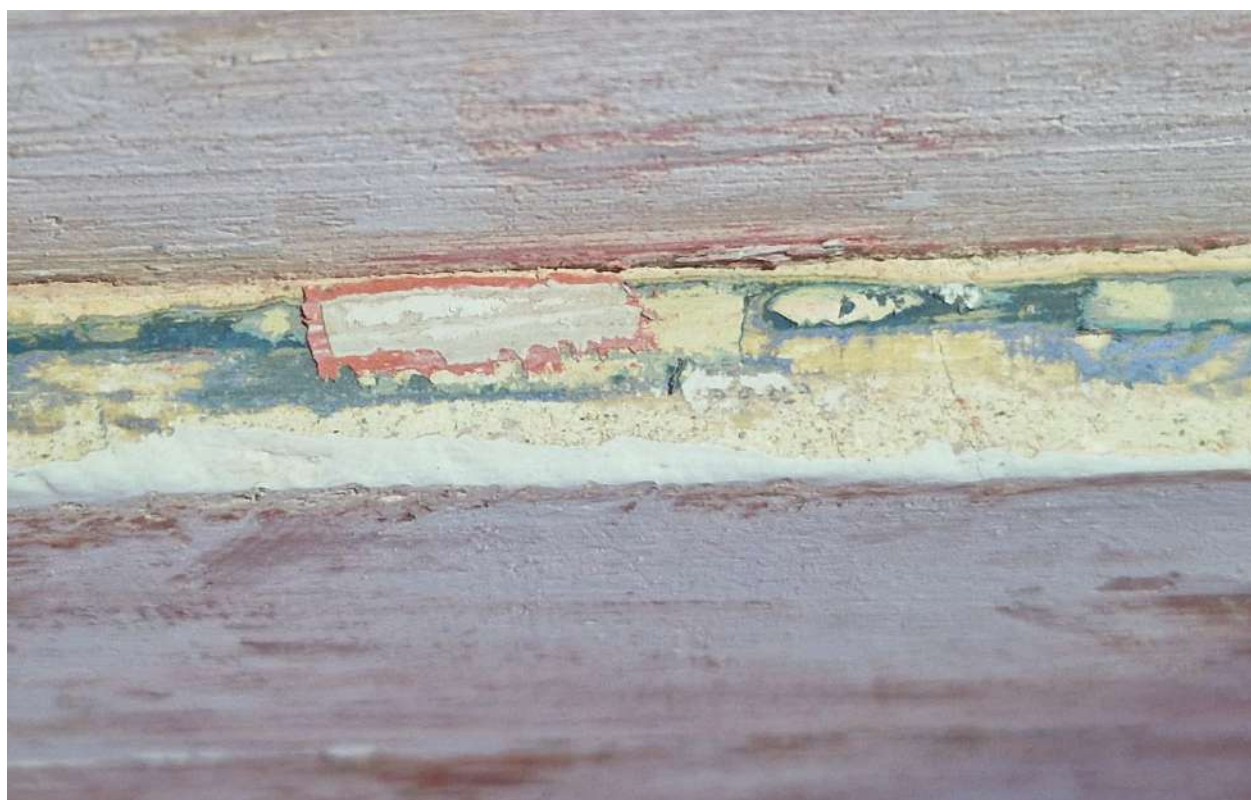
Patalpa 1-11. Tyrinėjama lubų zona Nr. 1 Plokštuma 3.
