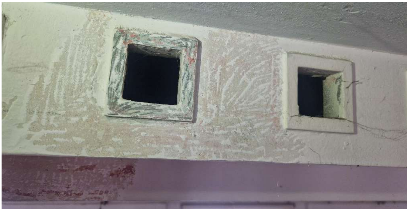
Patalpa 1-11. Tyrinėjama lubų zona Nr. 3. Plokštuma 2.
