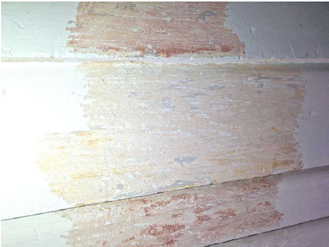
Patalpa 1-11. Tyrinėjama lubų zona Nr. 3. Plokštuma 9.
