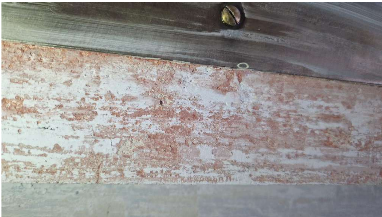
Patalpa 1-11. Tyrinėjama lubų zona Nr. 1 Plokštuma 6.
