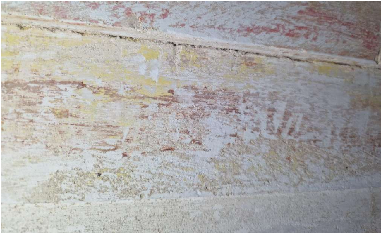
Patalpa 1-11. Tyrinėjama lubų zona Nr. 2 Plokštuma 1.
