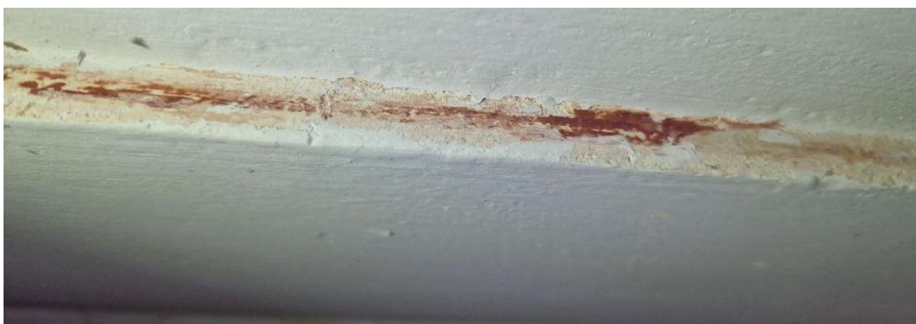
Patalpa 1-11. Tyrinėjama lubų zona Nr. 3. Plokštuma 4.
