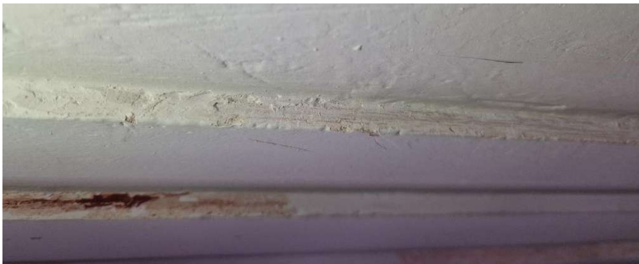
Patalpa 1-11. Tyrinėjama lubų zona Nr. 3. Plokštuma 5.
