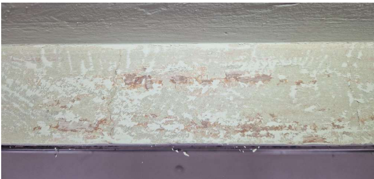
Patalpa 1-11. Tyrinėjama lubų zona Nr. 3. Plokštuma 1.
