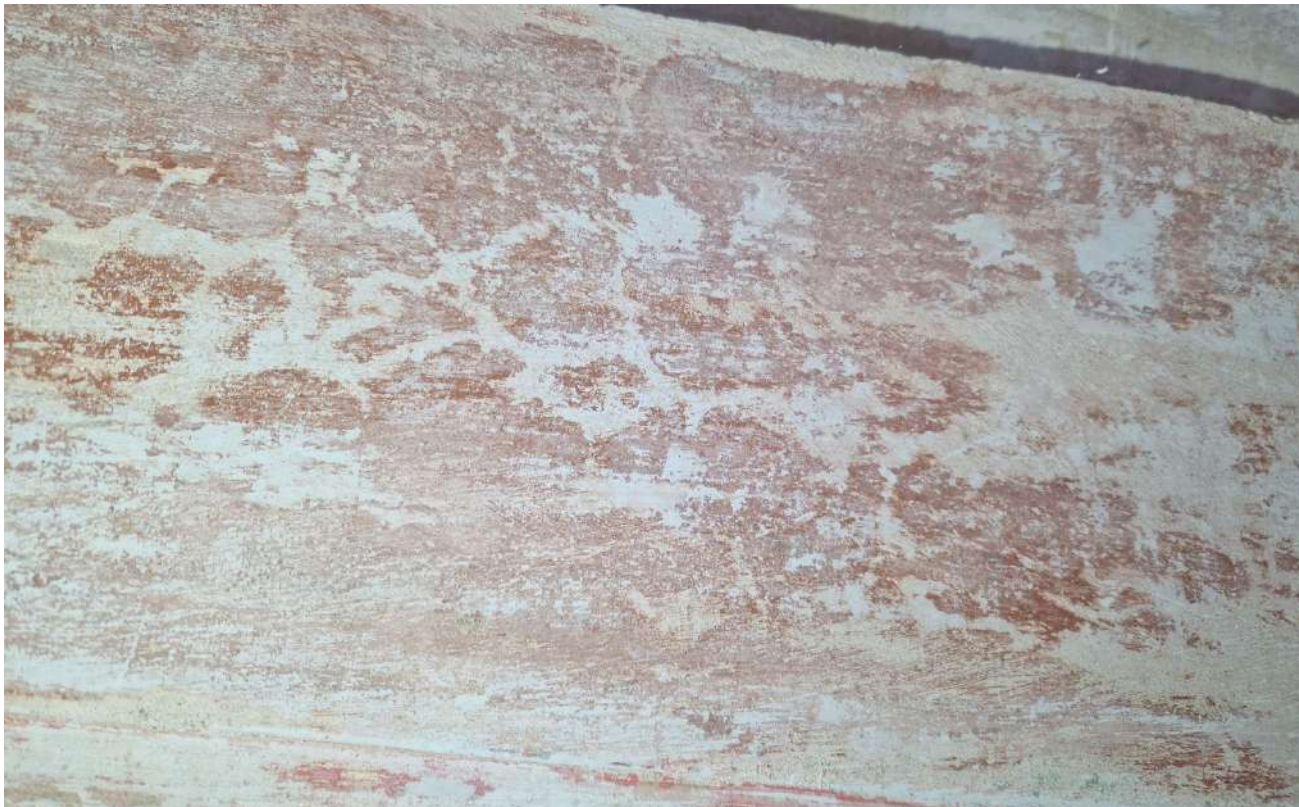
Patalpa 1-11. Tyrinėjama lubų zona Nr. 2 Plokštuma 3.
