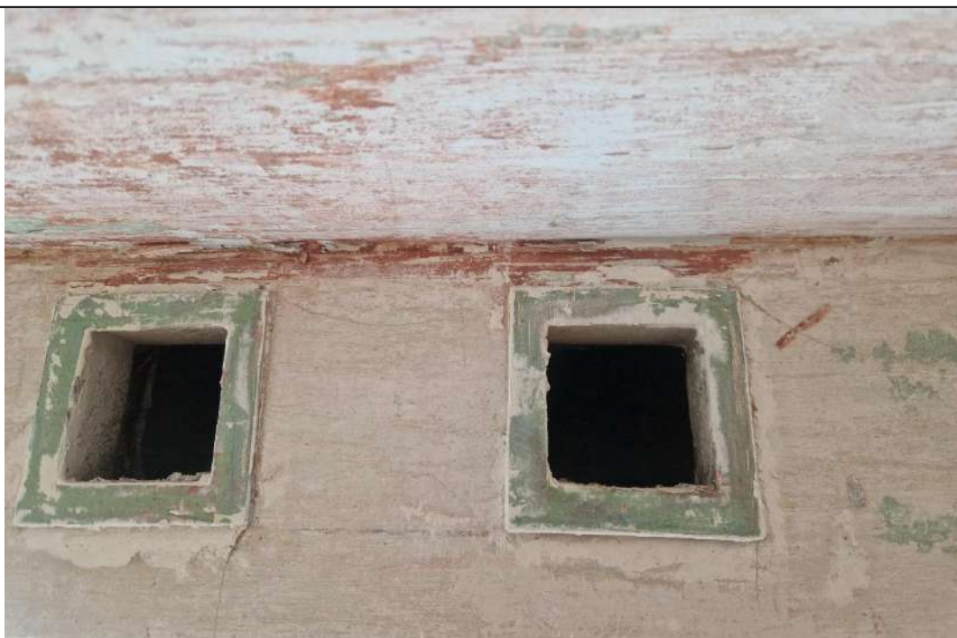
Patalpa 1-11. Tyrinėjama lubų zona Nr. 1 Plokštumos 2 ir 8.
