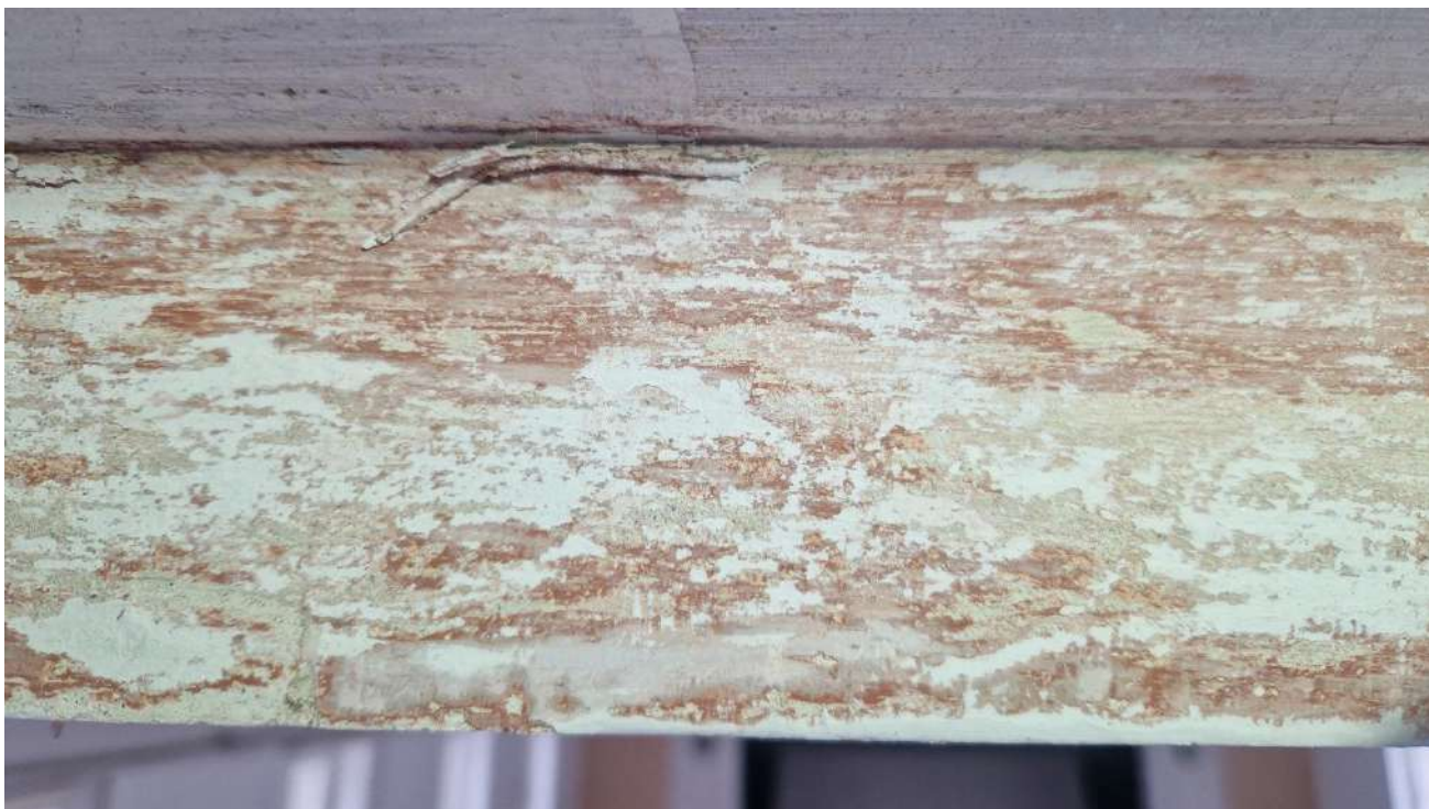
Patalpa 1-11. Tyrinėjama lubų zona Nr. 1 Plokštuma 1.
