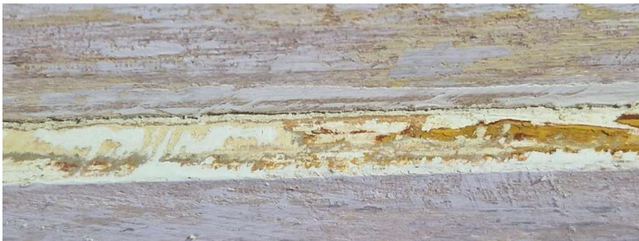
Patalpa 1-11. Tyrinėjama lubų zona Nr. 1 Plokštuma 4.
