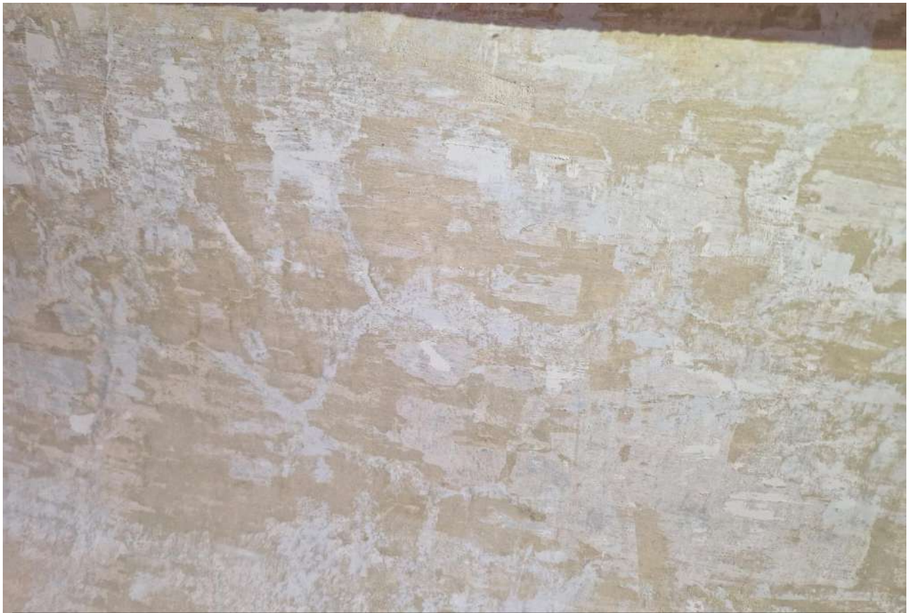
Patalpa 1-11. Tyrinėjama lubų zona Nr. 2 Plokštuma 4.
