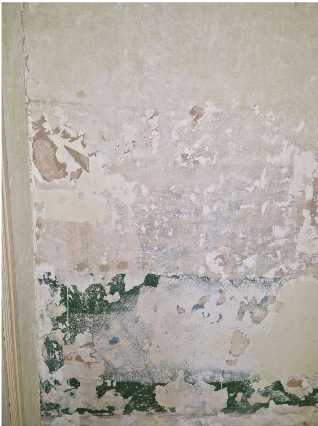
Patalpa 1-4. Sienos būklē remonto metu, nuskusti sluoksniņi.
