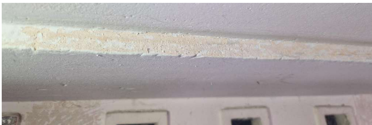
Patalpa 1-11. Tyrinėjama lubų zona Nr. 3. Plokštuma 3.
