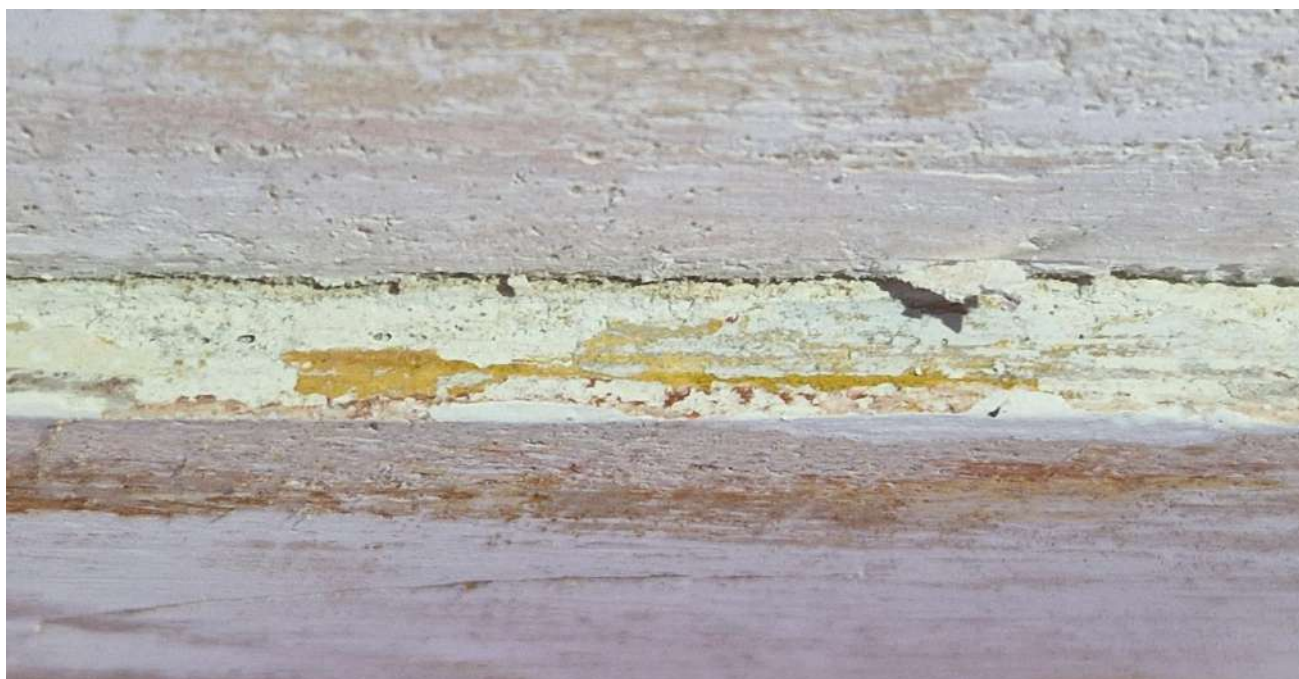
Patalpa 1-11. Tyrinėjama lubų zona Nr. 1 Plokštuma 5.
