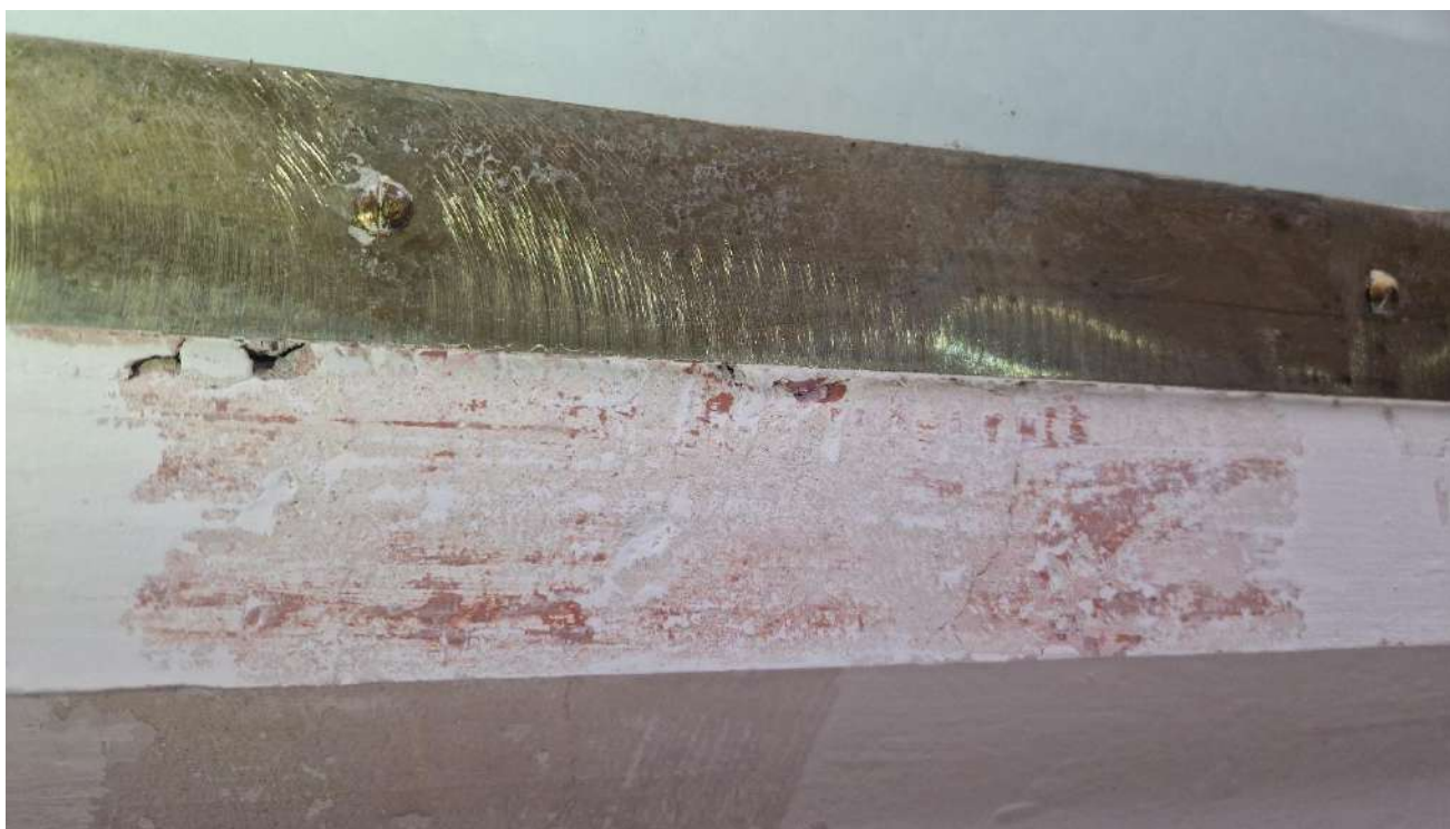
Patalpa 1-11. Tyrinėjama lubų zona Nr. 3. Plokštuma 6.
