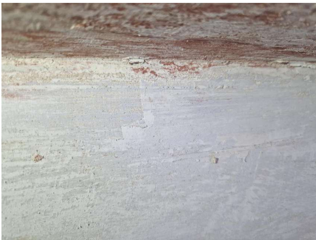
Patalpa 1-11. Tyrinėjama lubų zona Nr. 1 Plokštuma 7.
