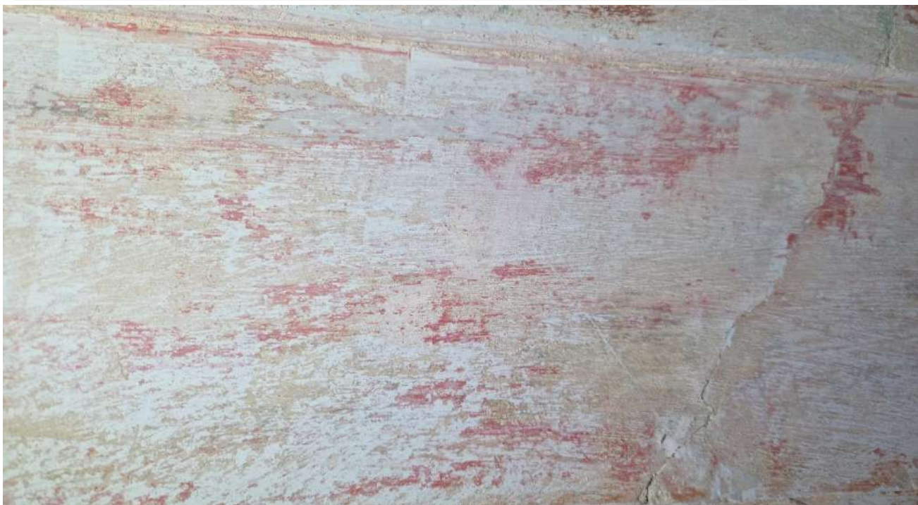
Patalpa 1-11. Tyrinėjama lubų zona Nr. 2 Plokštuma 2.
