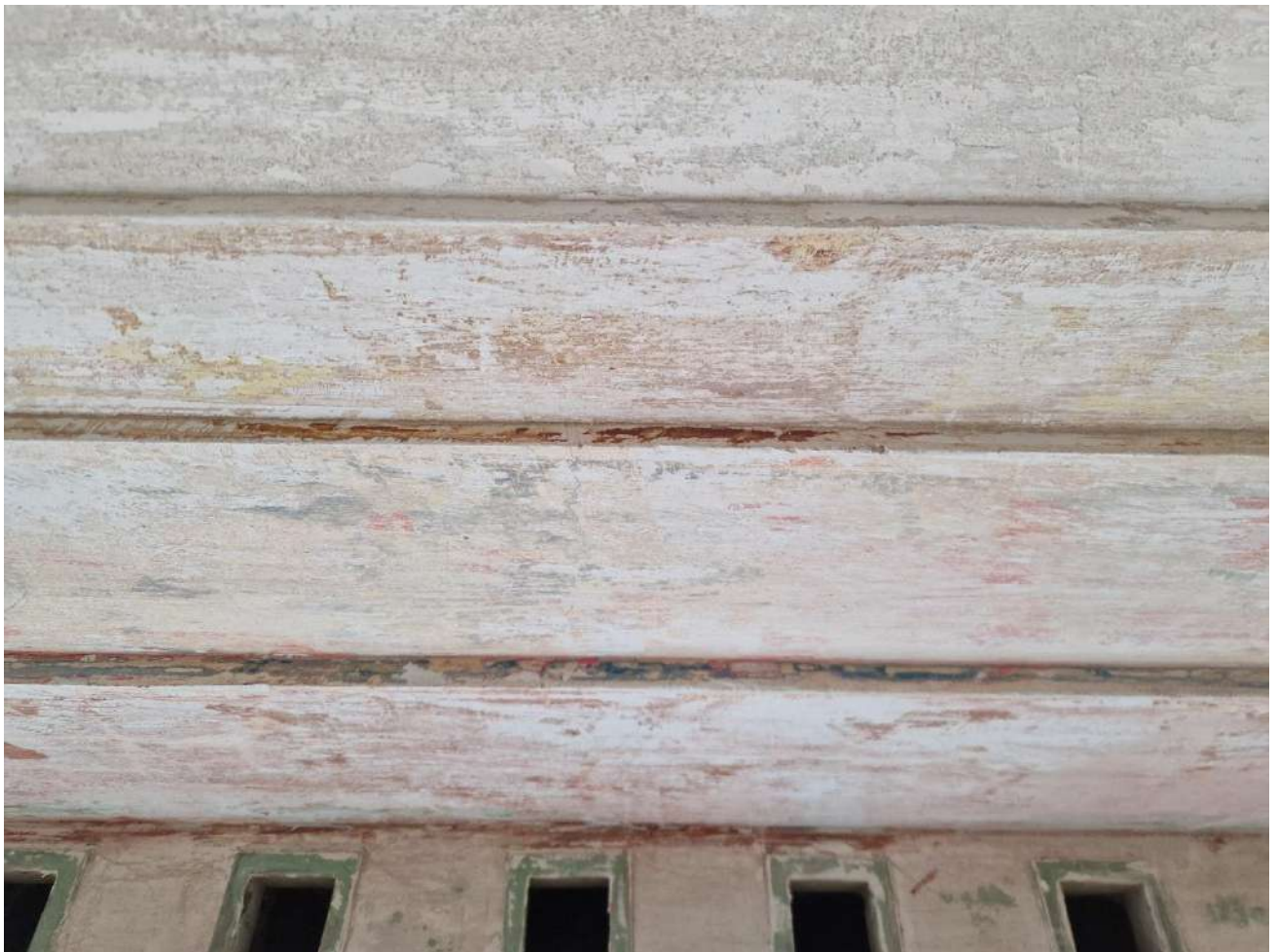
Patalpa 1-11. Tyrinėjama lubų zona Nr. 1 Visos plokštumos.
