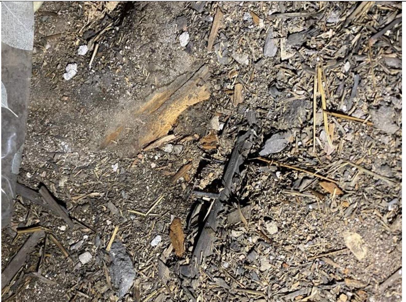
Perdangos sijų pažeidimai
