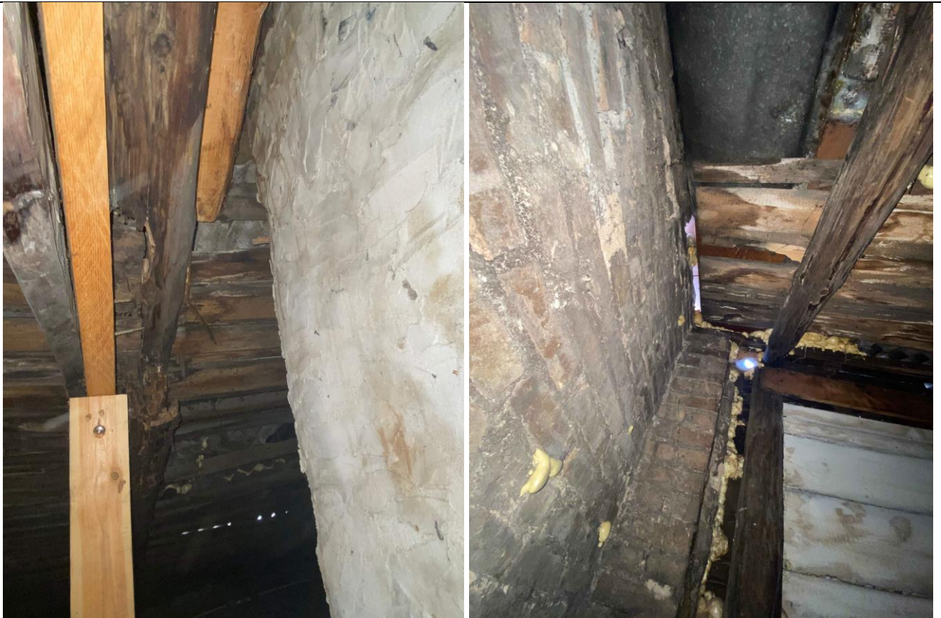
F 33 Sulūžusi gegnė ir Fixus mobilis komandos laikinai sutvirtinta stogo konstrukcija F34 Plyšiai tarp pastato mūrinės ugniasienės ir stogo
