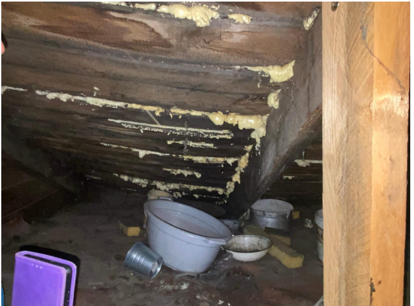
F 30, F31, F32 Ertmės pastato stoge. F32 Ilinkės stogas rytinėje kiemo fasado pusėje, F 13-būklė fasade
