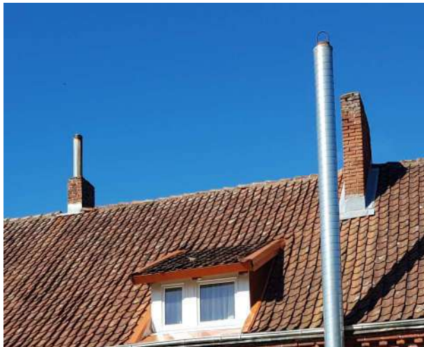
13 Pav. Rytų pusės mūro dumtraukiai, stogo dalies fragmentas
