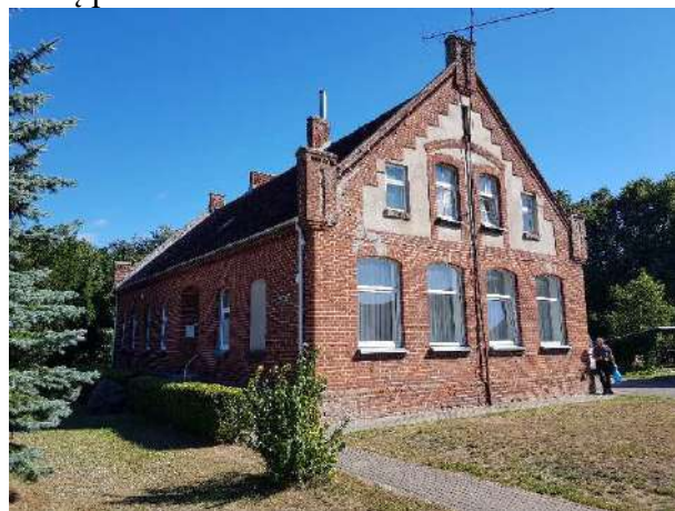
Pav. 10 Pietų pusės fasadas
