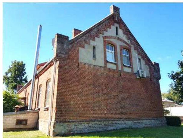
Pav. 2 Šiaurės pusės fasadas
