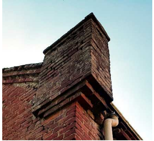
2 Pav. Šiaurinės pusės karnizo dalies bokštelis
