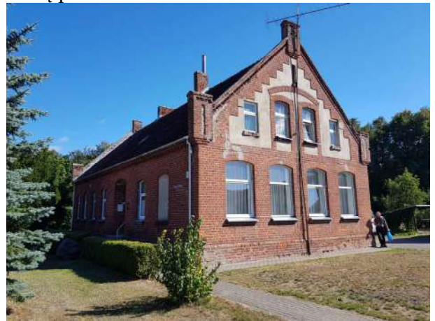
Pav. 10 Pietų pusės fasadas
