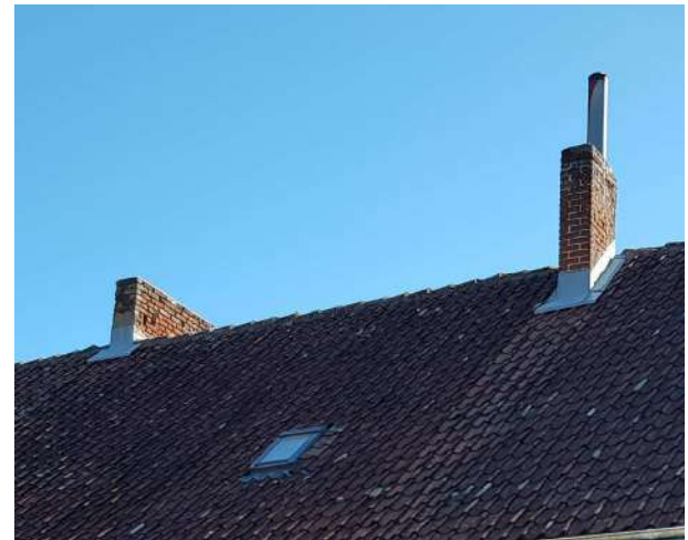
14 Pav. Vakarų pusės mūro dumtraukiai, stogo dalies fragmentas
