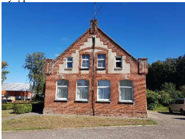
Pav. 9 Pietų pusės fasadas
