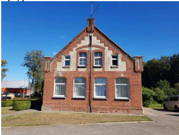
Pav. 9 Pietų pusės fasadas
