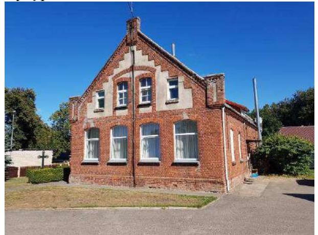
Pav. 8 Pietų pusės fasadas
