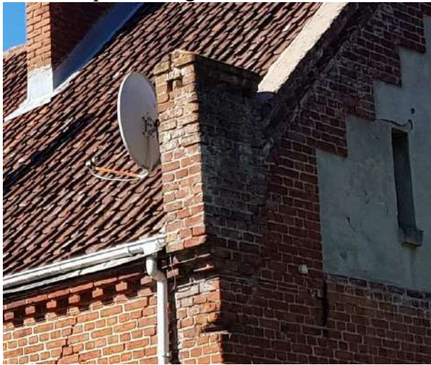
3 Pav. Šiaurinės pusės karnizo dalies bokštelis
