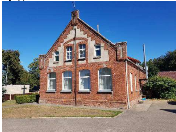
Pav. 8 Pietų pusės fasadas
