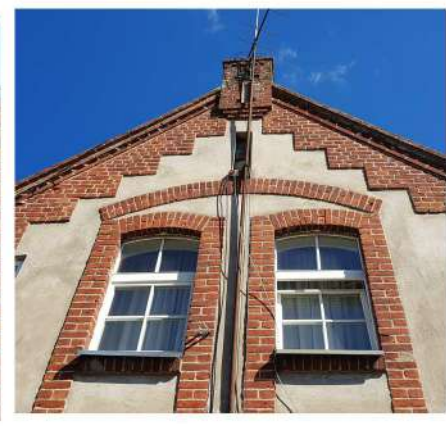
Palangėse ir anų skliautuose, karnize naudotas specifinis plytų rišimo būdas - pasukant šonu, ištraukiant į išorę ar įstrižai...
