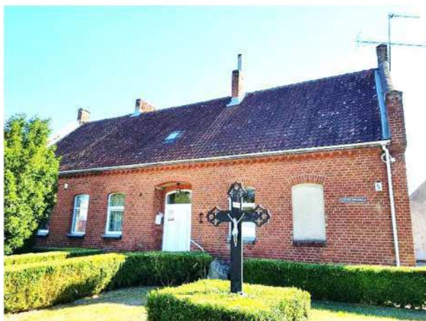
Pav. 1 Vakarų pusės fasadas
