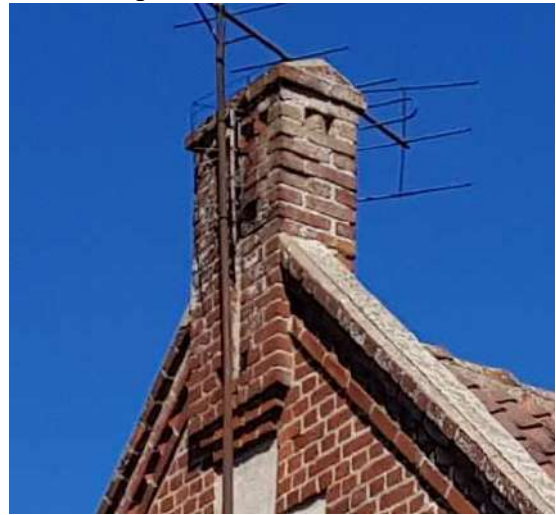
4 Pav. Pietinė pusės kraigo dalies bokštelis
