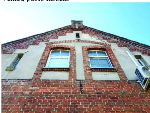
Pav. 3 Šiaurės pusės fasadas
