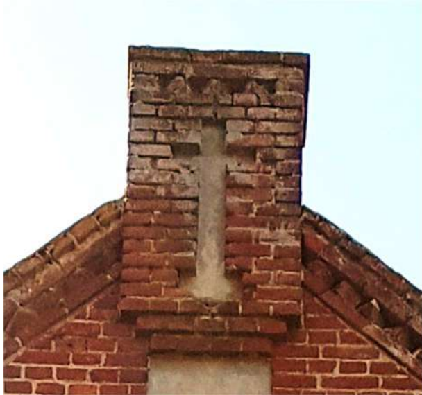
1 Pav. Šiaurinės pusės kraigo dalies bokštelis
