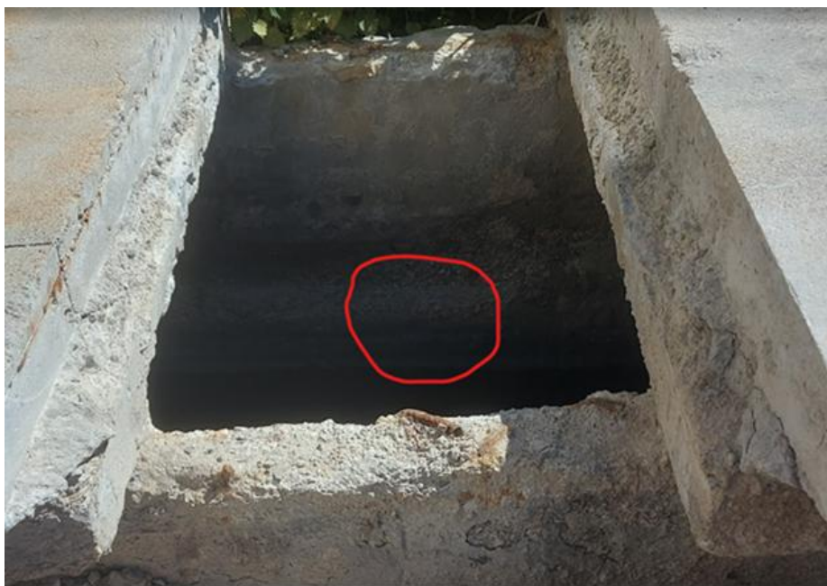
2 pav. Bendras konstrukcijos vaizdas ir betoninių fragmentų paėmimo vieta (pažymėta raudonai)
