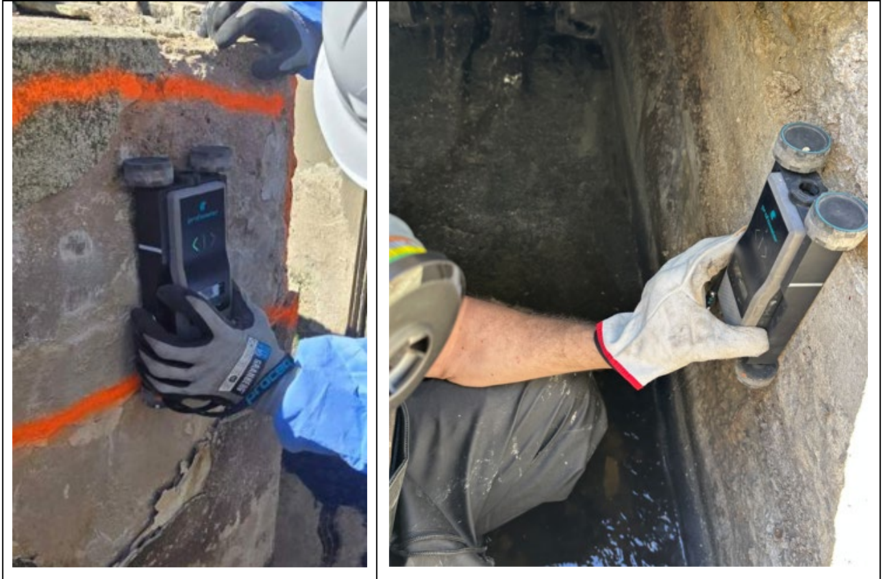
Pav. 7.2 Armatūros apsauginio sluoksnio storio ir armatūros išdėstymo instrumentinis tyrimas
