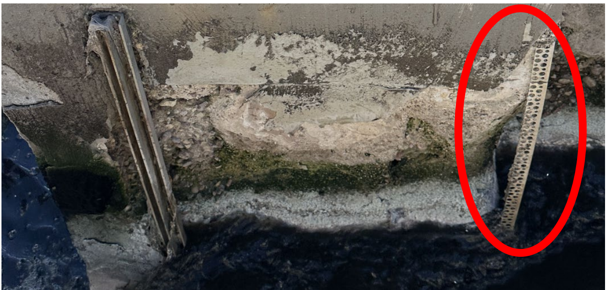
7.3 Suiręs slopinimo pertvarų betono sluoksnis vandens/oro zonoje. Atviri užpildai.
