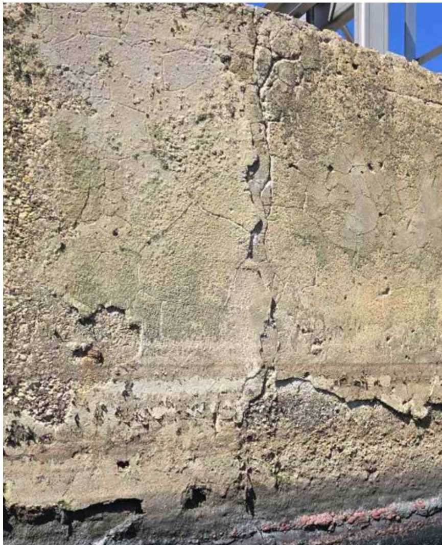
7.11 Plyšiai konstrukcijose (sienose, pertvarose).
