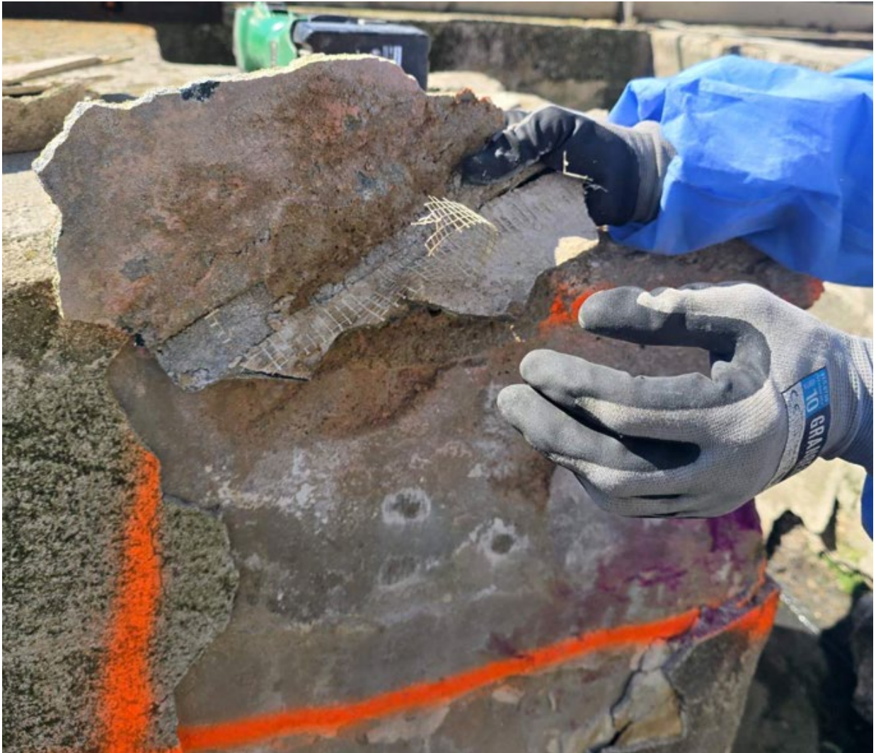
7.3 Suiręs slopinimo pertvarų betono sluoksnis vandens/oro zonoje. Atviri užpildai.
