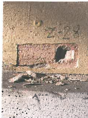
F-26. PR fasado liUNETė virš įvažos. Zondažas Z-28.
