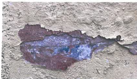
F-36. ŠV fasado I a. sienos plokštumos dažų atodanga. Zondažas Z-40. SL-1.
