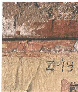
F-18. PR fasado II a. menamo rizalito piliastro tinko dekoras. Zondažas Z-19. SL-1.
