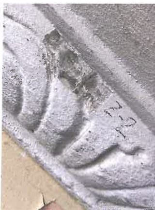
F-3. PR fasado frontono karnizas. Zondažas Z-2. SL-2.
