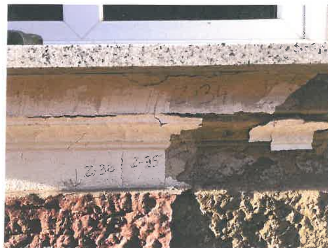
F-28. PR fasado I a. polanginė trauka ir polangio dekoras. Zondažų Z-34, Z-35 ir Z-36 situacija.
