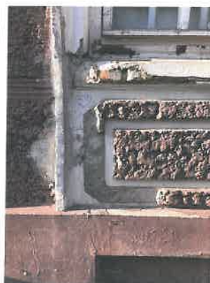
F-30. PR fasado I a. polanginių stačiakampių profiliuotų tinko dekorų situacija.
