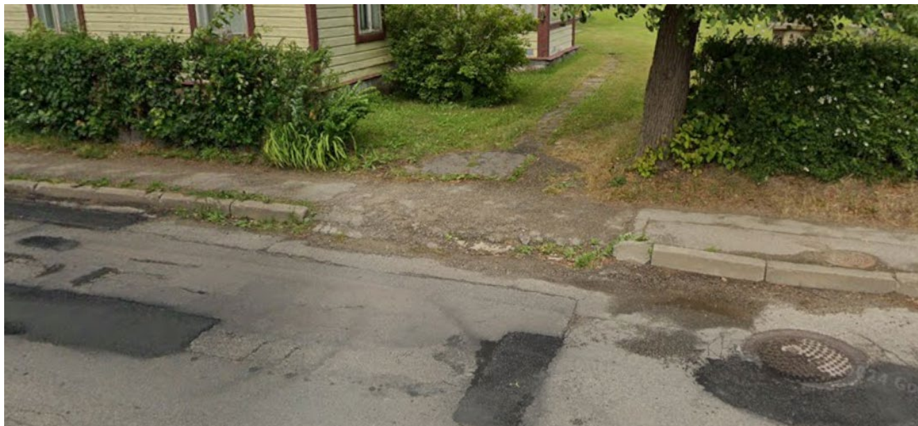
4 pav. Šaltupės g. šaligatvių esama būklė
