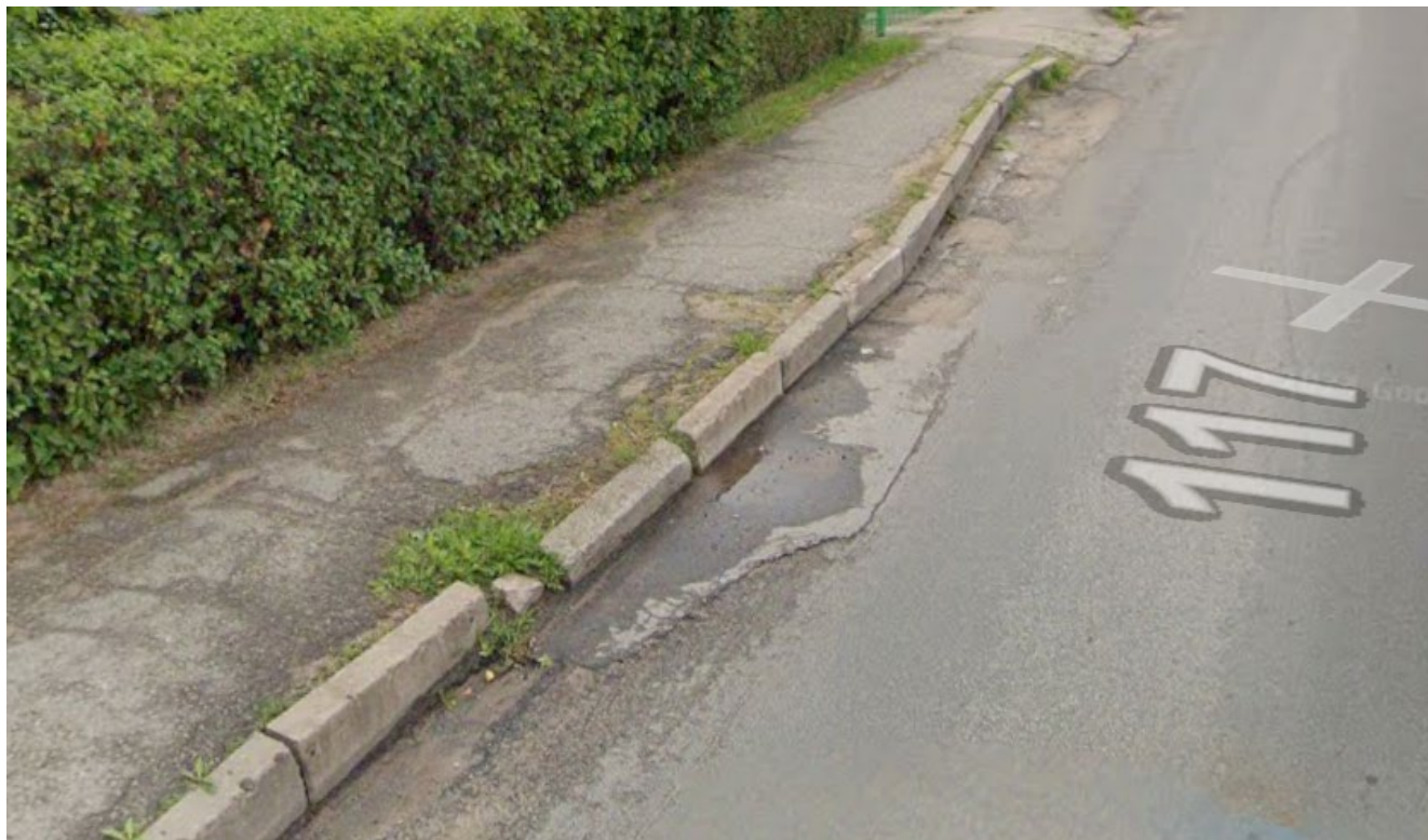
2 pav. Šaltupės g. šaligatvių esama būklė
