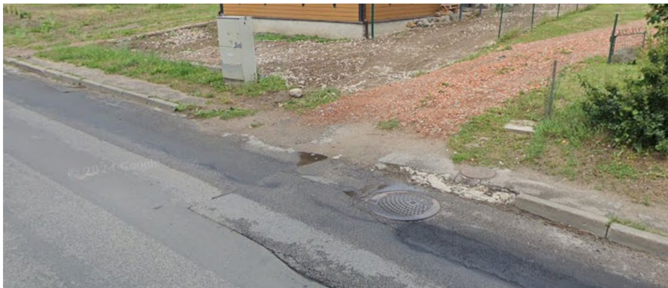
6 pav. Šaltupės g. šaligatvių esama būklė
