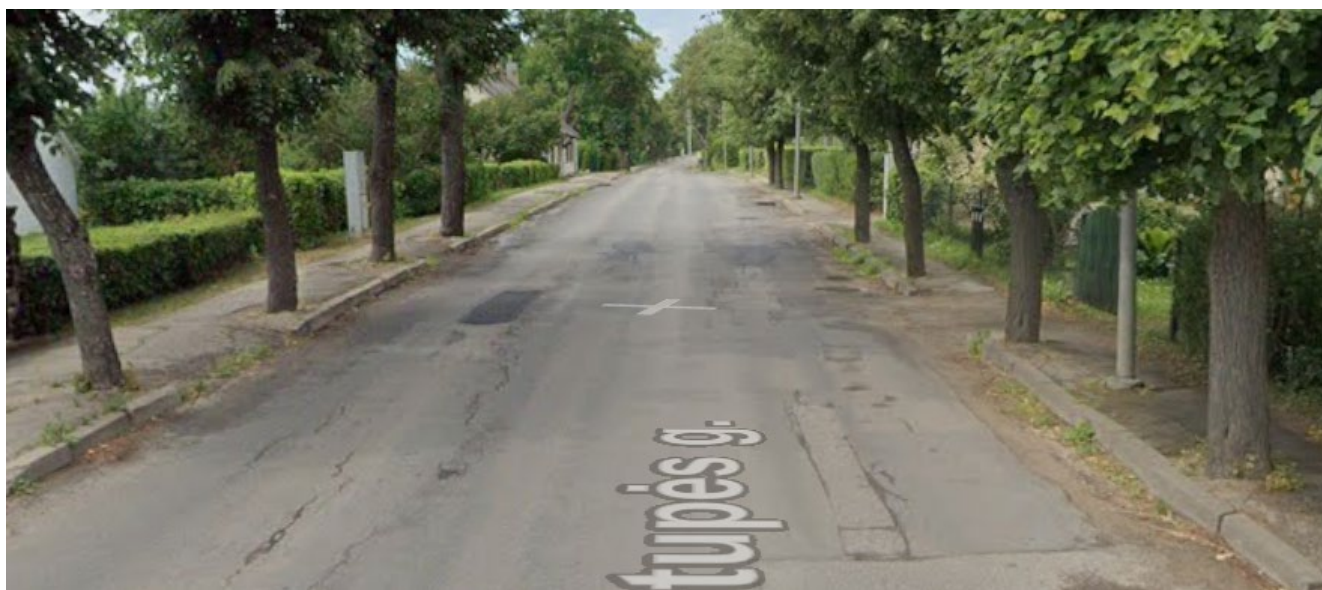
3 pav. Šaltupės g. šaligatvių esama būklė
