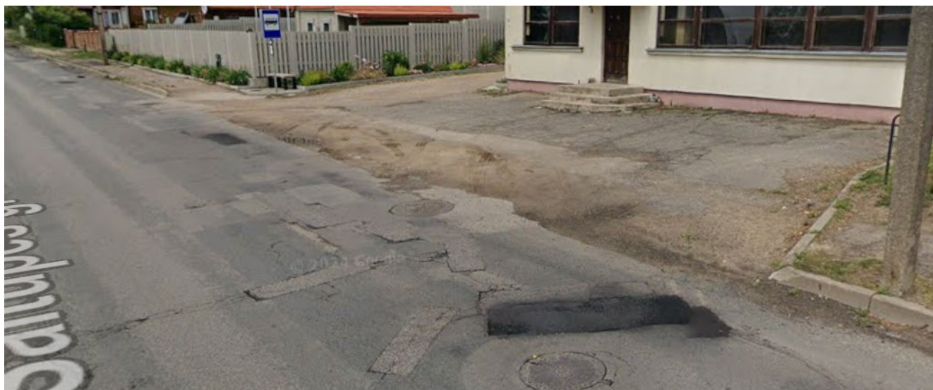
5 pav. Šaltupės g. šaligatvių esama būklė
