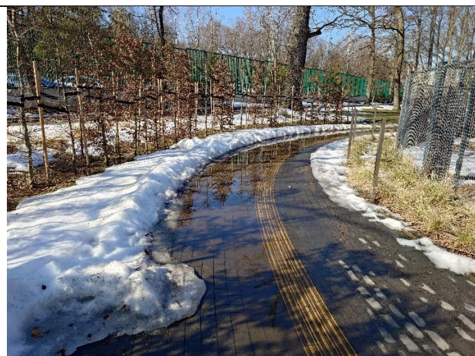
6 pav. Medžių šešėlio pusėje taip pat matomas sniego tirpsmo vandens įtaka Korsakų voljero teritorijai. Daroma prielaida, kad sniegas buvo sandėliuojamas išorinėje pėsčiųjų tako pusėje, taip pat pėsčiųjų tako nuolydis leido apsaugoti tirpsmo vandens patekimui į voljero teritoeiją.
