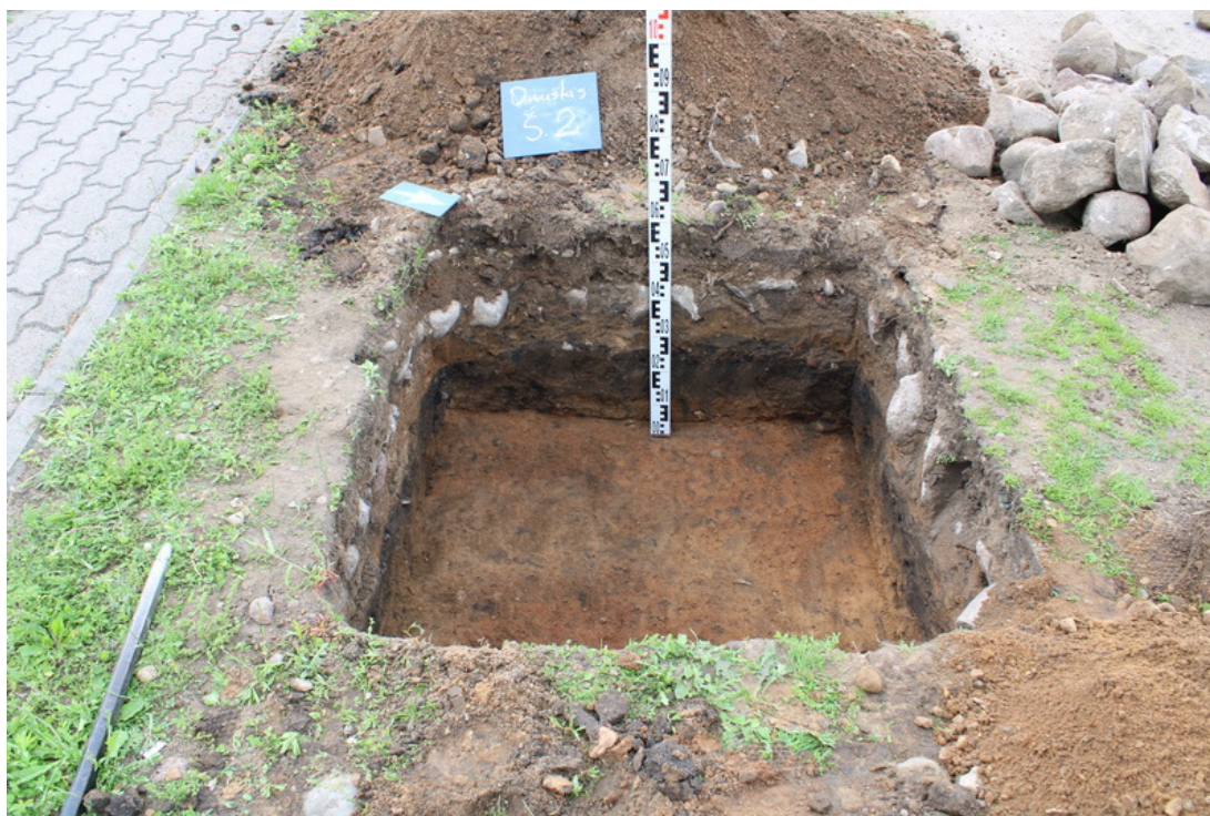
Šurfas Nr. 2, PV sienelė. Gylis 0,6 m (fotografuota iš ŠR)
