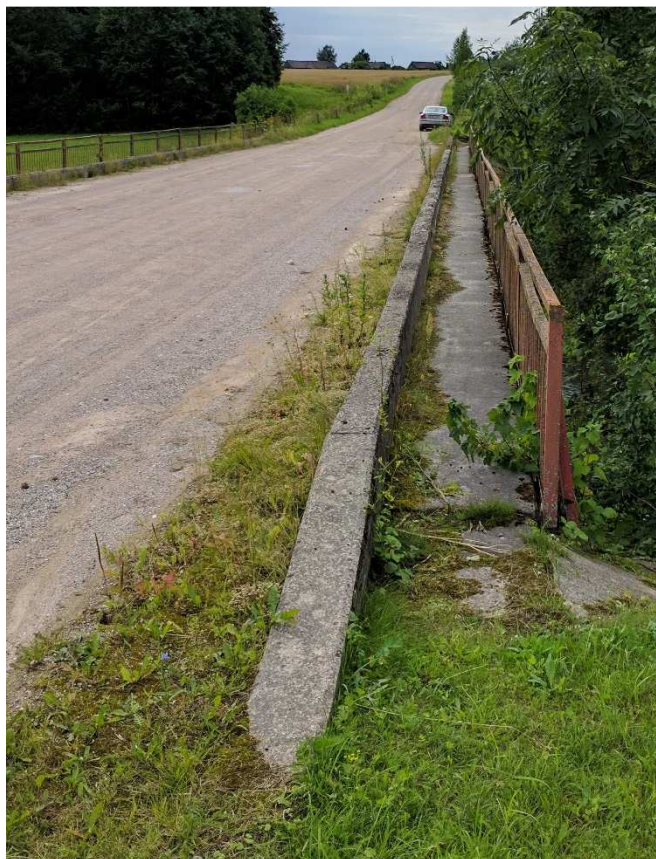
10 pav. Lietaus šulinėliai užnešti žvyru, apaugę žole
