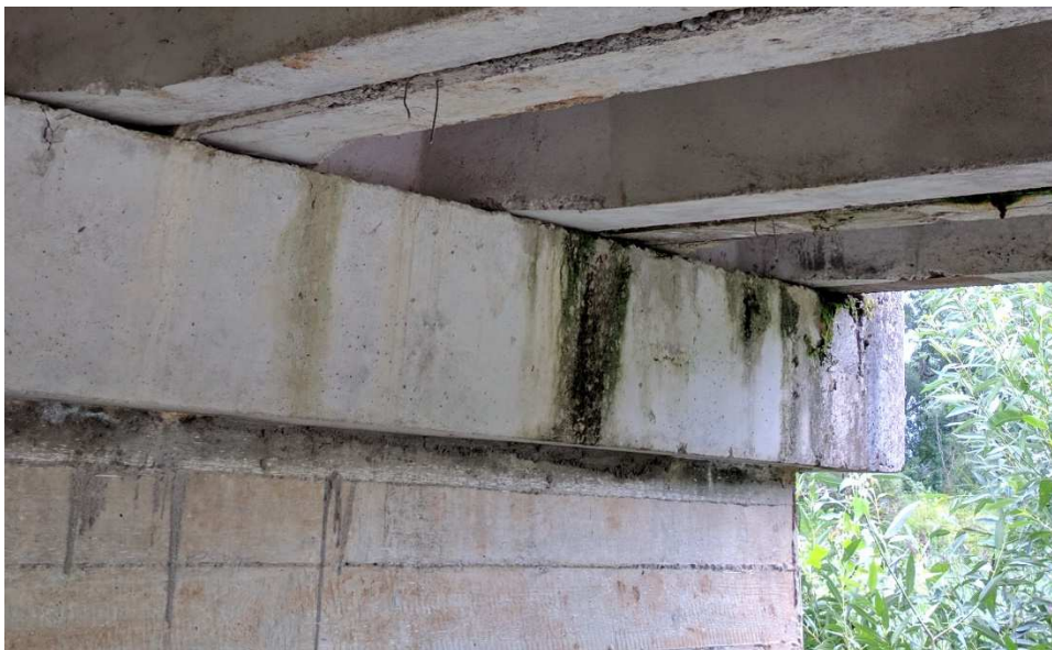
14 pav. Atramų betonas dėl nesandaraus deformacinio pjūvio drėkinamas
