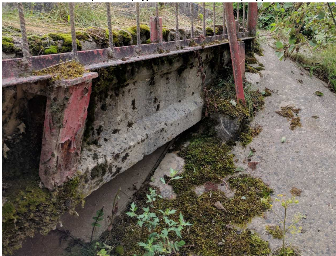
13 pav. Krantinių atramų kraštai užnešti žemėmis
