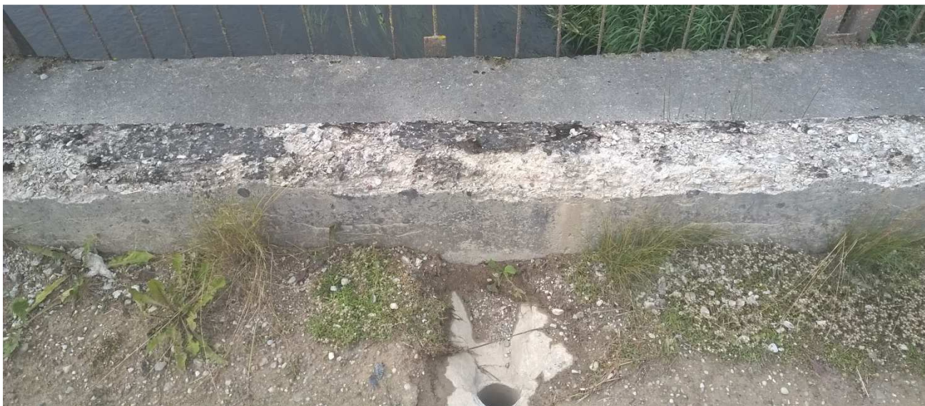
5 pav. Gelžbetoninio borto paviršius nelygus, vietomis aptrupėjęs
