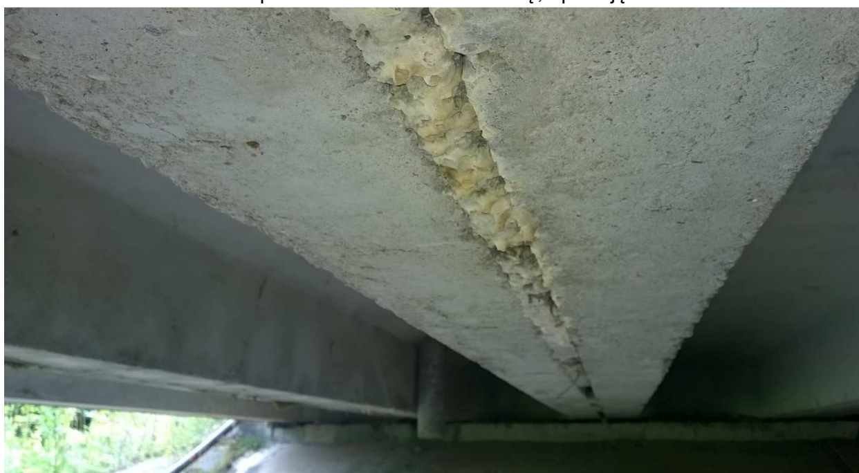
9 pav. Hidroizoliacija vietomis pažeista, matyti sijų sumonolitavimo vietose išplautos baltos kalkių nuosėdos
