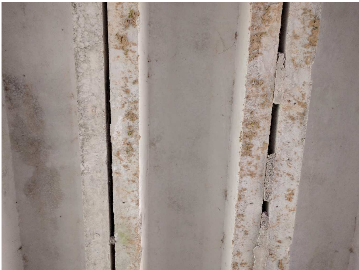
12 pav. Ištrupėjęs sumonolitinis tarp sijų
