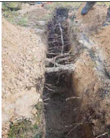
3 pav. Skeletinių ir smulkių medžio šaknų išsaugojimo kasant tranšėją pavyzdžiai. KŽEG archyvo nuotraukos.
