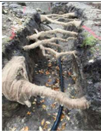
3 pav. Skeletinių ir smulkių medžio šaknų išsaugojimo kasant tranšėją pavyzdžiai. KŽEG archyvo nuotraukos.
