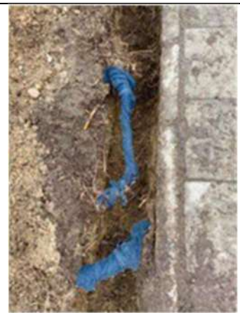
3 pav. Skeletinių ir smulkių medžio šaknų išsaugojimo kasant tranšėją pavyzdžiai. KŽEG archyvo nuotraukos.
