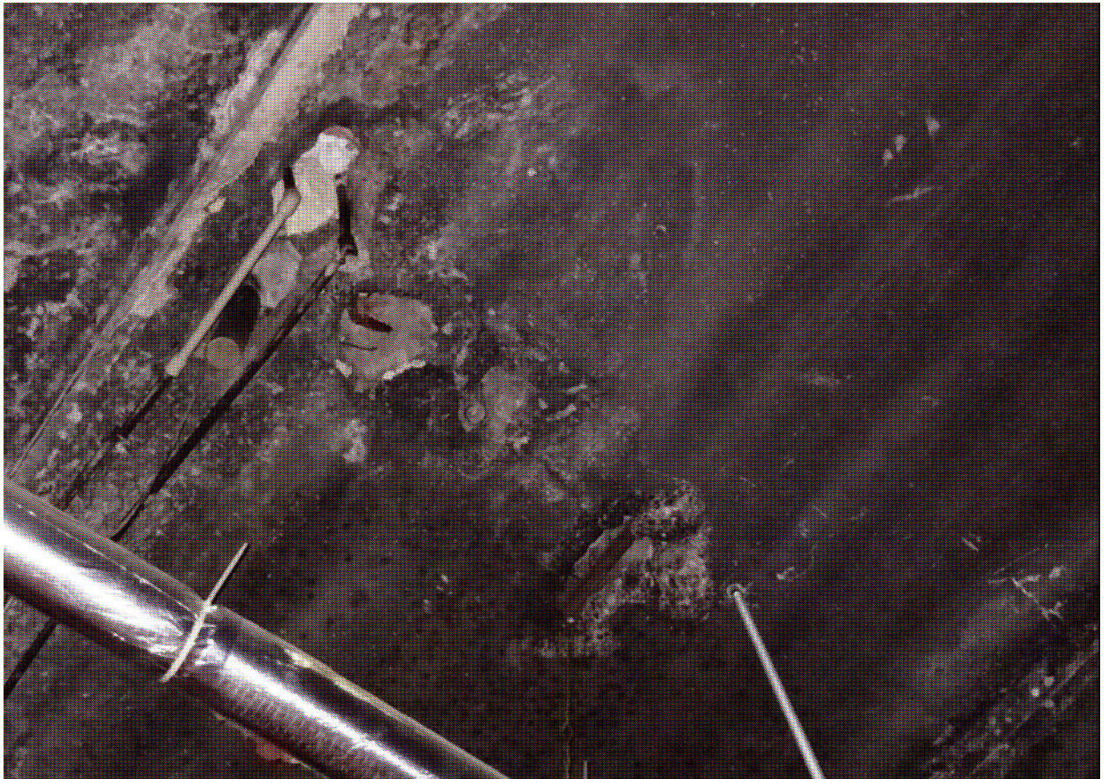
Nuotrauka su armatūros korozijos nuo perdangos plokštės apatinio paviršiaus atplėštais betonų plotais.
