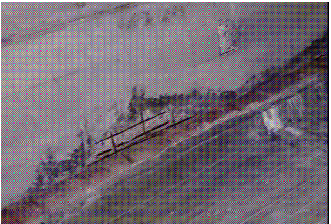
Nuotrauka su armatūros korozijos nuo perdangos plokštės apatinio paviršiaus atplėštais betonų plotais.
