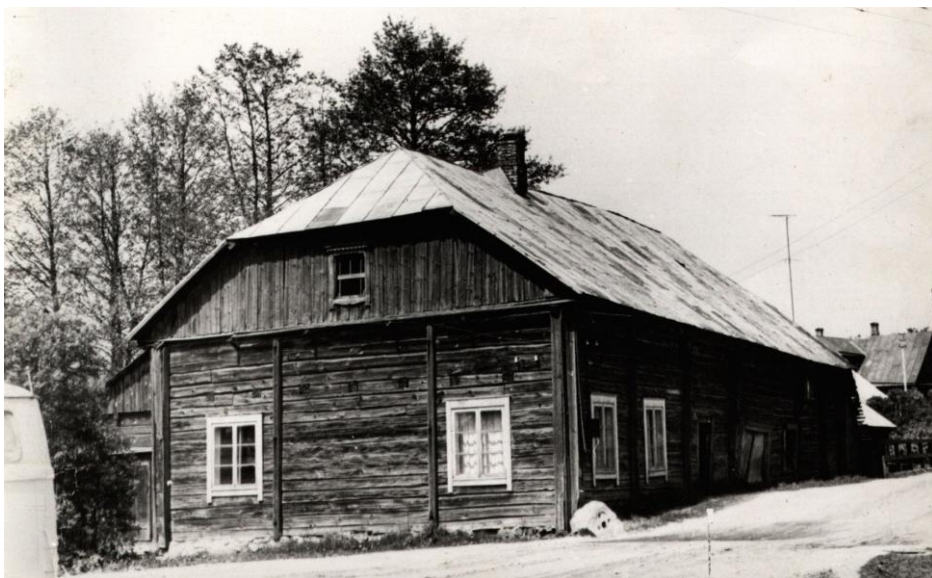
Stogas dengtas skarda
