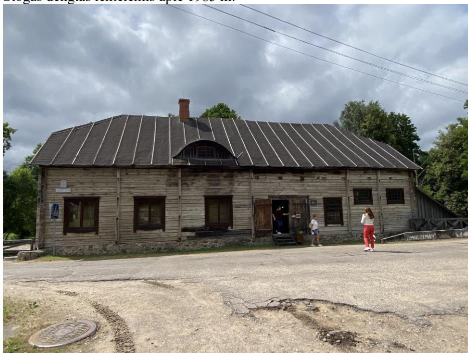
Stogas dengtas ruberoidu ant lentelių.
