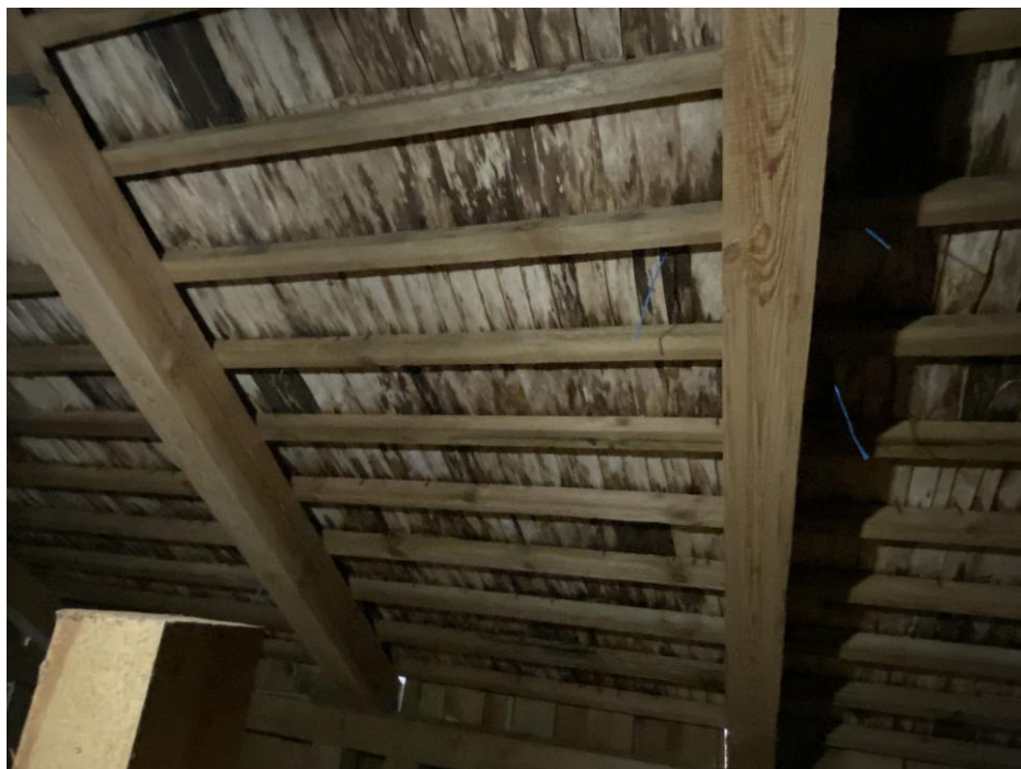
Esama padėtis. Pastogės vaizdas su buvusia lentelių danga po ruberoidu(virš šildomų patalpų).
