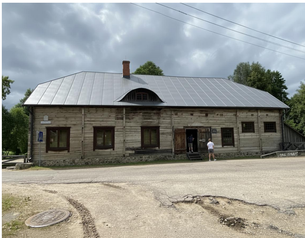
Vaizdas 1 po remonto.
