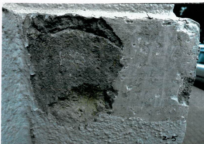
F-3. Zondažas Z-5. Atidengtas ankstyvesnis dažymo paviršius. SL-1 .
