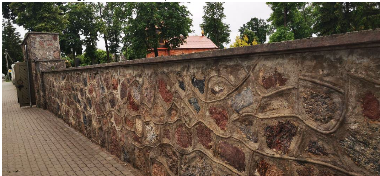
Centrinės tvoros dalies būklė patenkinama, fragmentiškai pažeistas akmenų mūras ir siūlės, bei dengianti betoninė plokštė
