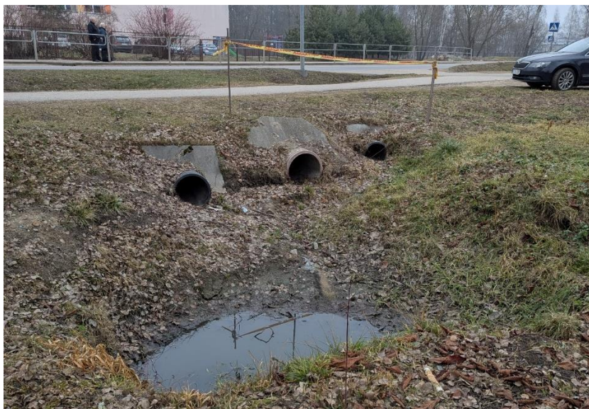
Pav. 4 Žemiausia Sodų g. vieta (LST1), šalia Skaistės 1-oji g. 4, kurioje susirenka paviršinės nuotekos nuo Sodų g. ir aplinkinių gyvenamųjų namų.
