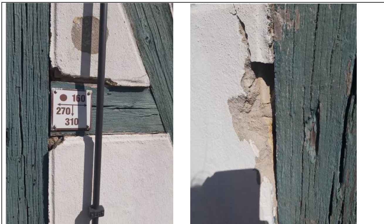
FF 05. Priestato PV fasado tinko būklės fotofiksacija
