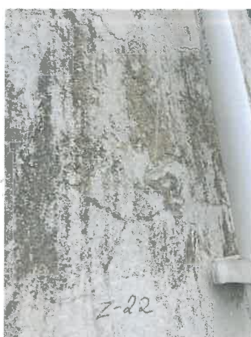
F-31. V fasadas, II a. sienos plokštumos dažų atodanga. Zondažas Z-22. SL-1.
