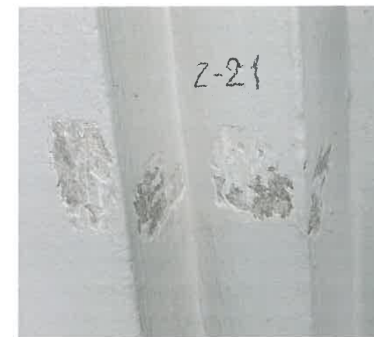
F-30. Šiaurinis fasadas, pagr. įėjimo profiliuotas tinko dekoras. Zondažas Z-21. SL-1.
