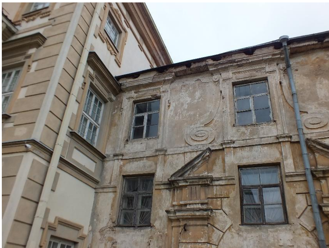
2 pav. Šiaurinė vakarų fasado dalis
