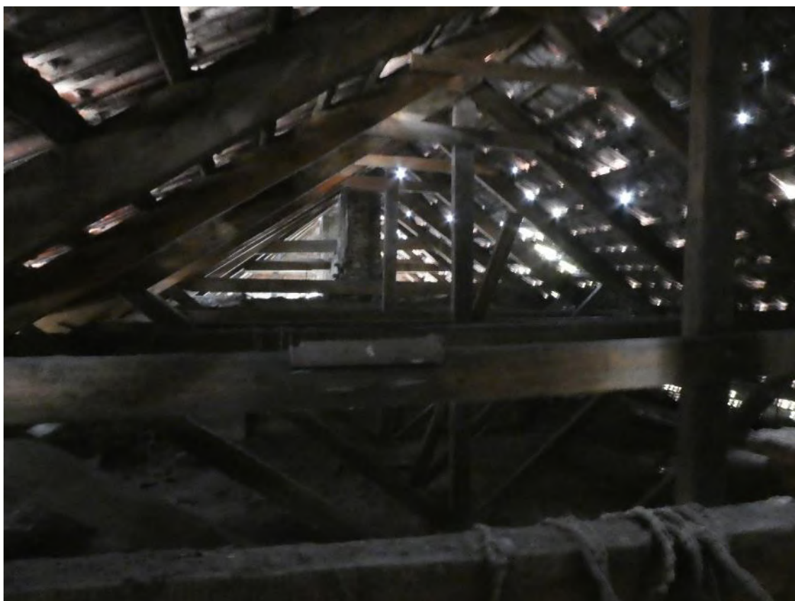
16 pav. Pastato stogo kopnstrukcijos šiaurinė dalis.
