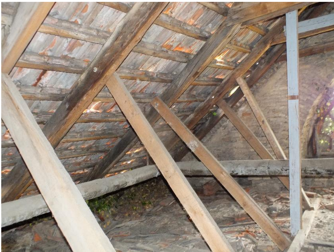
15 pav. Pastato stogo konstrukcijos.
