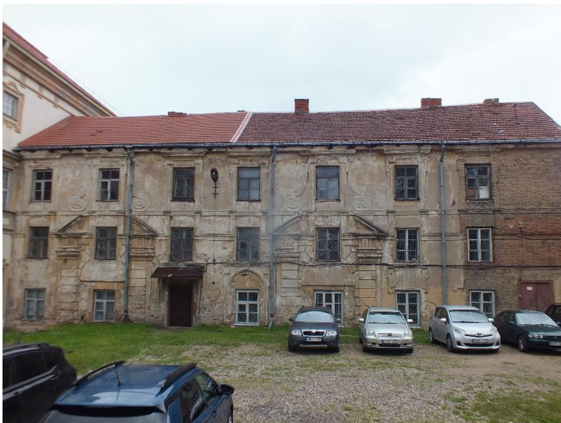
1 pav. Vakarinis pastato fasadas.
