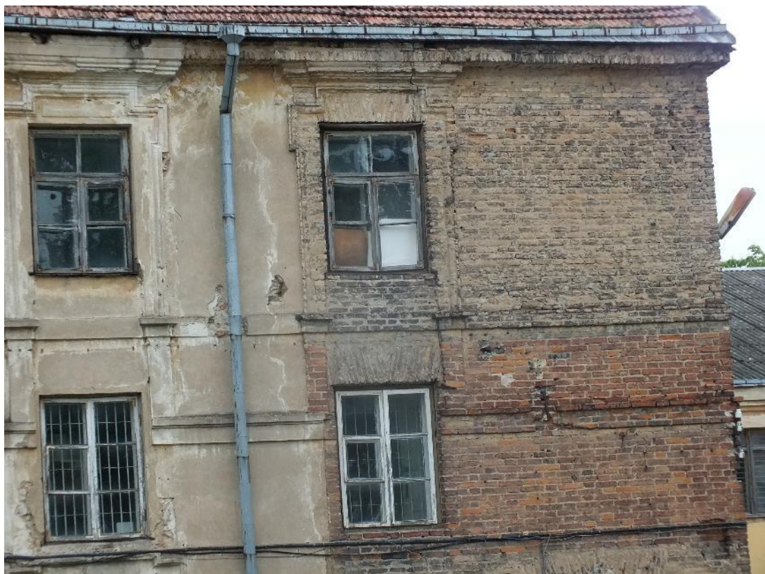
3 pav. Rytinė vakarų fasado dalis.
