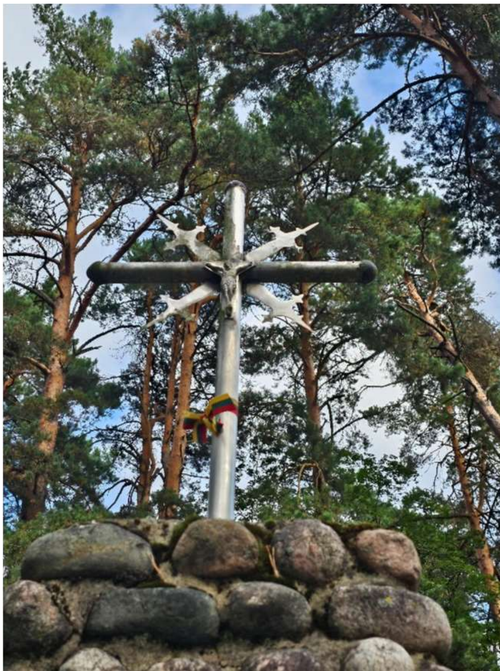
17. Paminklo metalinis kryželis padengtas purvu ir biologine tarša, tačiau korozijos nepaveiktas, paviršius tolygus, vientiso atspalvio.
