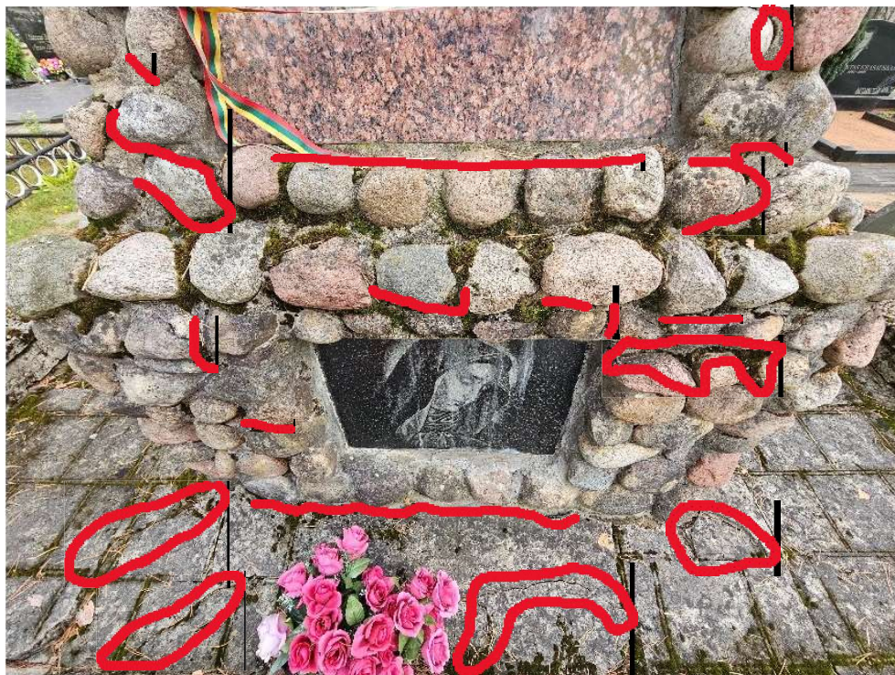
14. Paminklo siūlės išsilaikiusios neblogai, bet daug kur yra atšokimų tarp įmūrytų akmenų bei granitinių plokščių. Matosi smulkūs įskilimai. Suskilęs grindinys.
