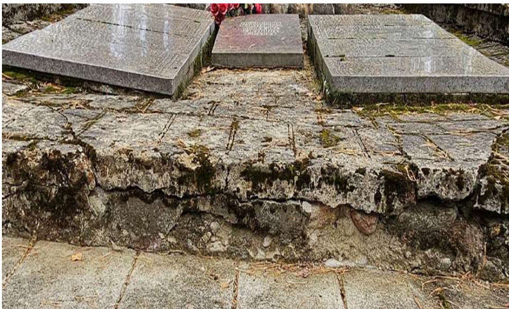
7. Paminklo grindinys suskilęs, vietomis susmegęs į žemę yra tinko netekčių, smarkiai apaugęs, padengtas purvu. Granitinės atminimo plokštės pakrypusios.
