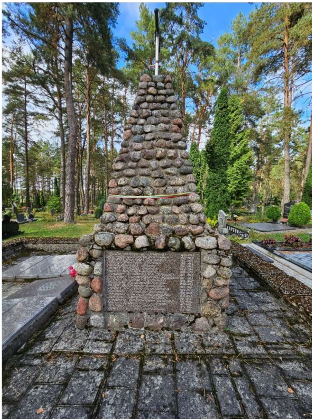
3. Paminklo bendras vaizdas iš dešinės pusės, matosi įvairūs užteršimai, nešvarumai, tinko dekoru netektys, suskilusios siūlės tarp įmūrytų akmenų.
