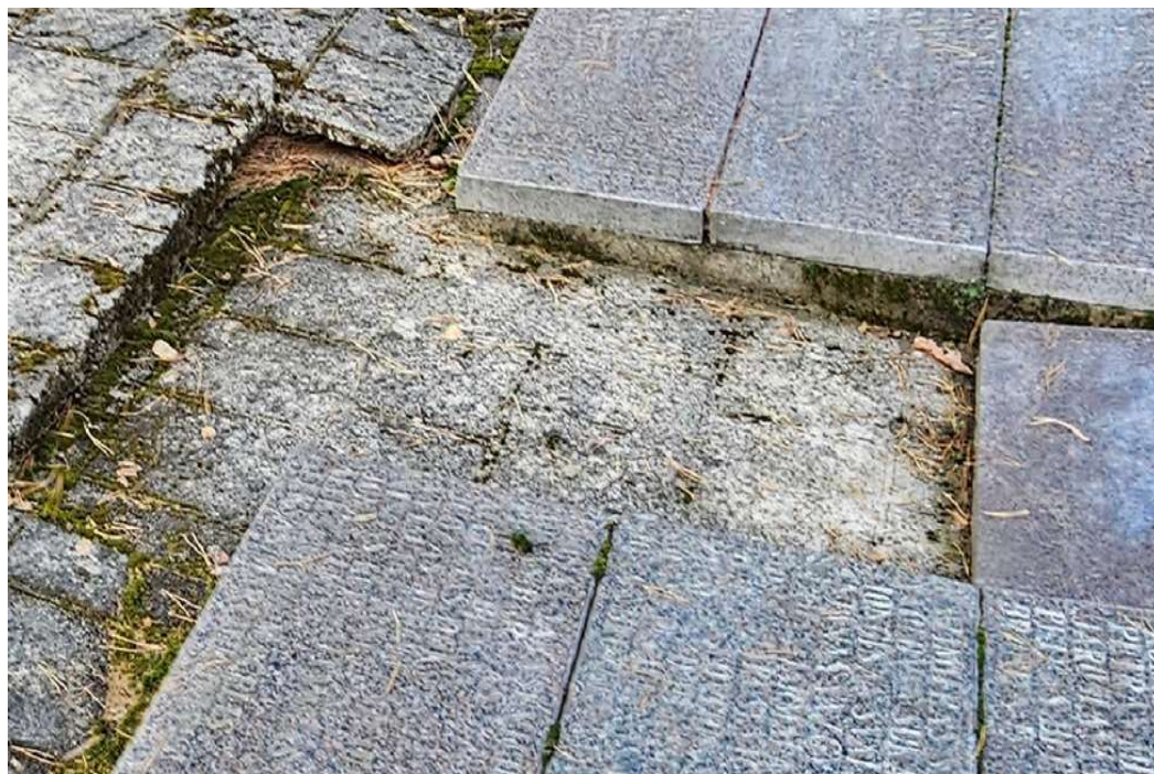
8. Paminklo grindinys suskilęs, vietomis susmegęs į žemę, siūlės tarp granitinių plokščių apaugusios samanomis, yra daug purvo.
