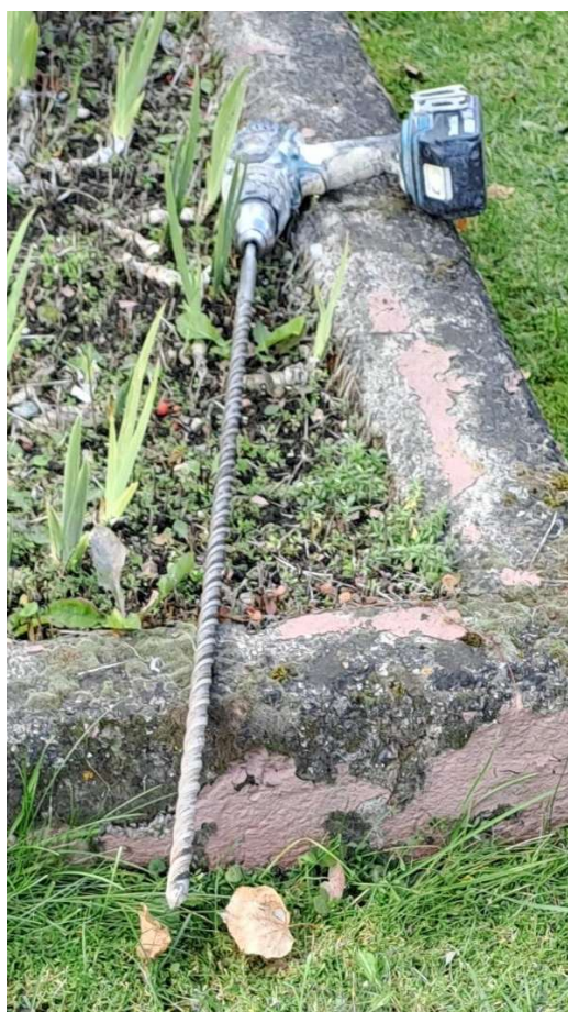
Paminklo pirminių laiptelių ieškojimas zonduojant 1 m ilgio grąžtu ir autentiškų fragmentų atkasimas.
