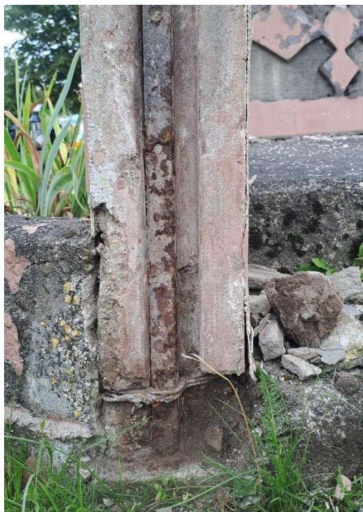
Paminklo tvorelės stulpelių neautentiški tvirtinimo elementai. Autentiški vartelių tvirtinimo.
