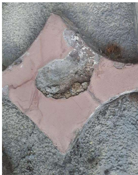
Paminklo apatinės dalies būklė – nubyrojimai, remonto tinkliuku pasekmės, biopažaida, skilimai, tinko atšokimai.
