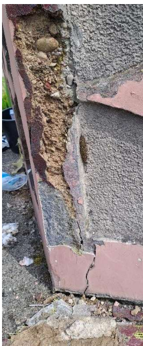
Paminklo apatinės dalies būklė – nubyrojimai, remonto tinkliuku pasekmės, biopažaida, skilimai, tinko atšokimai.
