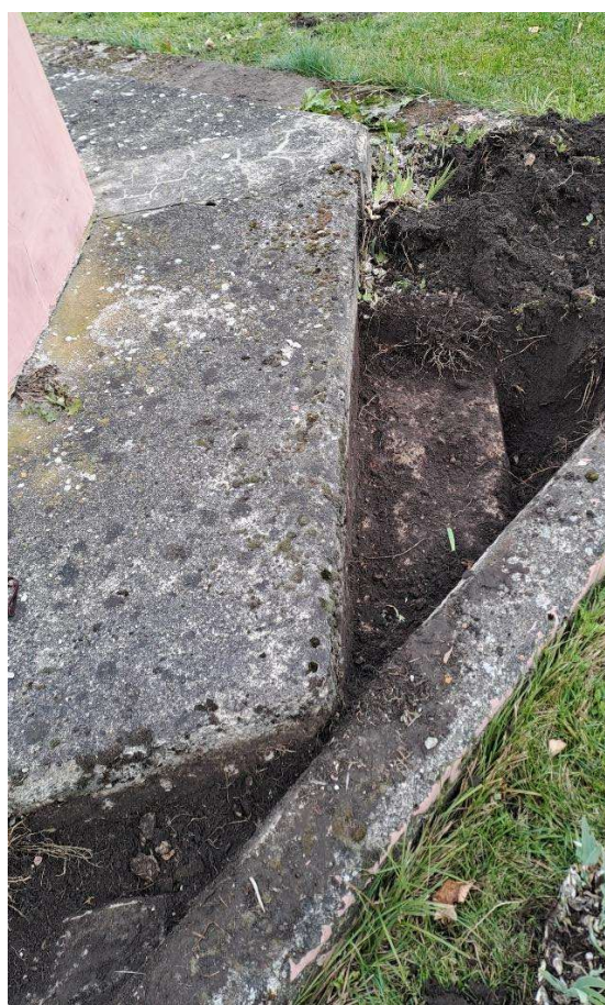
Paminklo pirminių laiptelių ieškojimas zonduojant 1 m ilgio grąžtu ir autentiškų fragmentų atkasimas.
