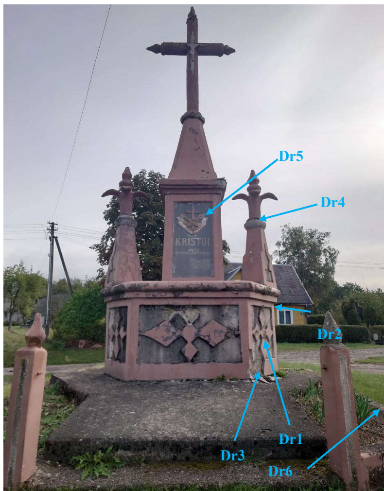
12 pav. Paminklas su pažymėtomis mėginių paėmimo vietomis užterštumui vandenyje tirpiomis druskomis nustatyti
