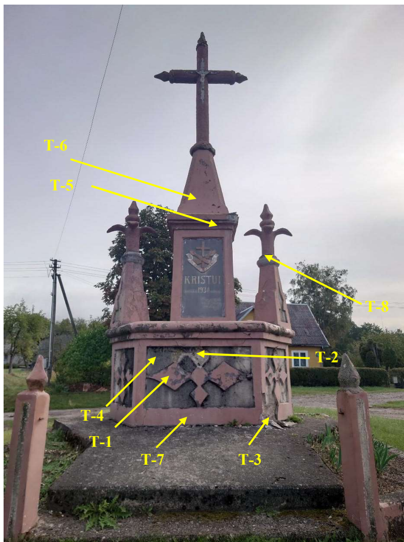
1 pav. Paminklo nuotrauka su pažymėtomis mėginių paėmimo vietomis tinko vizualinei ir mikroskopinei, cheminei bei granulimetrinei analizėms atlikti
