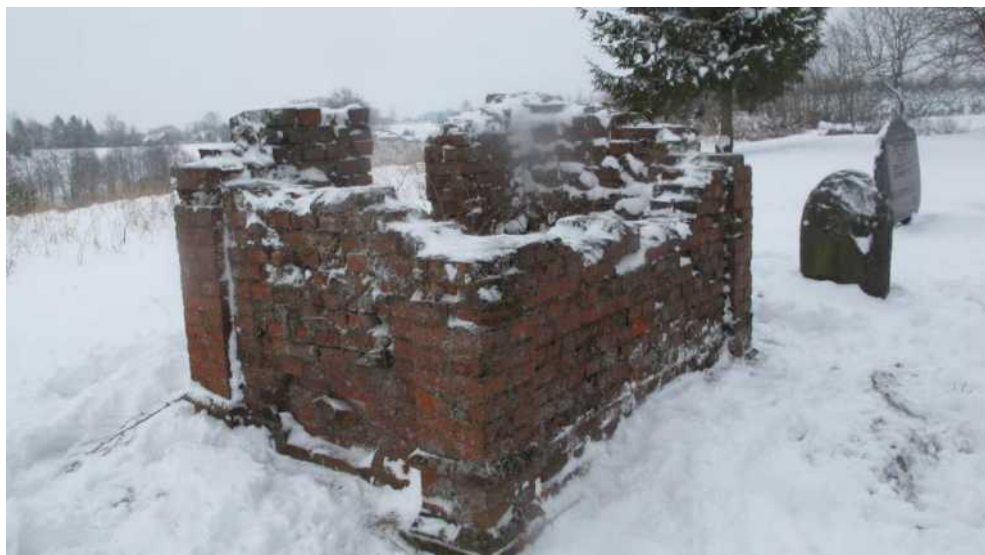
Ohelio liekanos šiaurinėje sklypo dalyje. Vaizdas iš PV pusės
