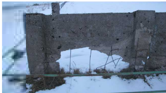
Gelžbetoninės tvoros fragmentas
